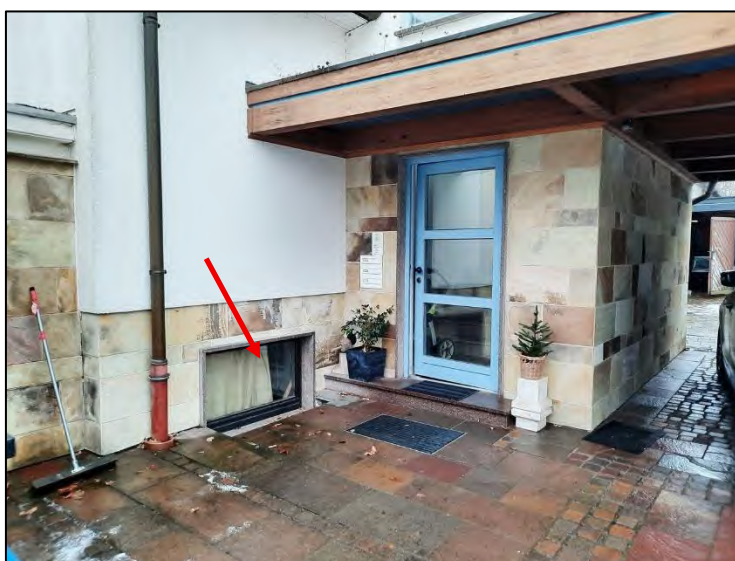
Abb. 3: Hauseingang; links (Pfeil) Küchenfenster
