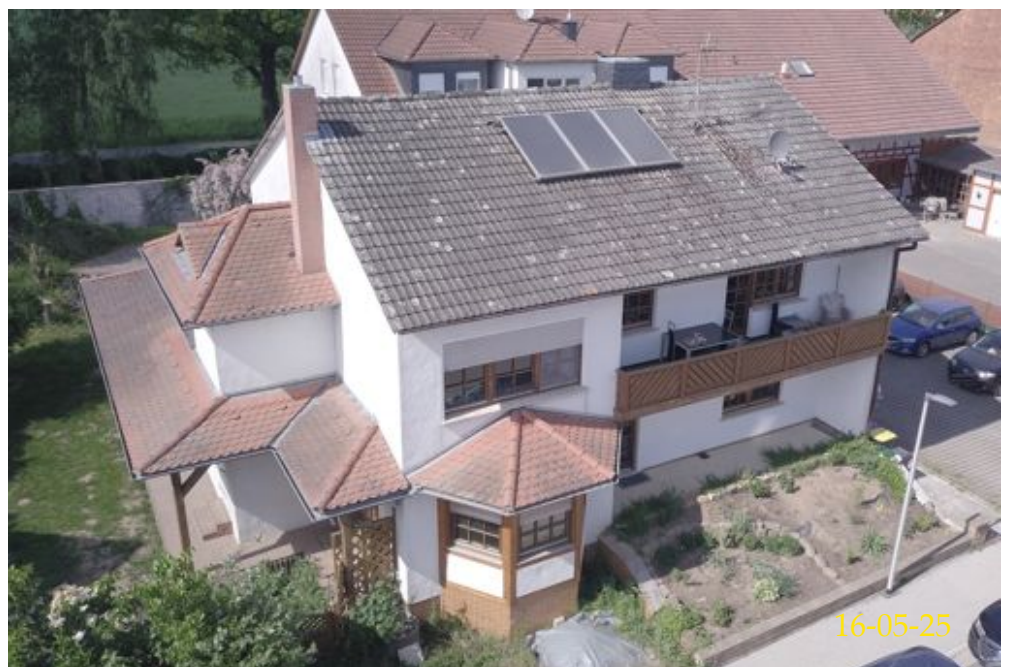
Gesamtansicht von Süden
