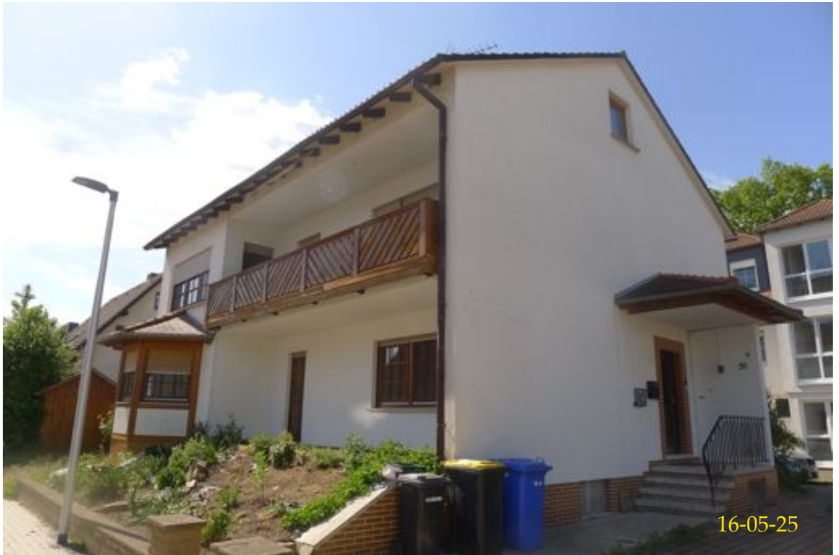
Straßenansicht von Süd-Osten
