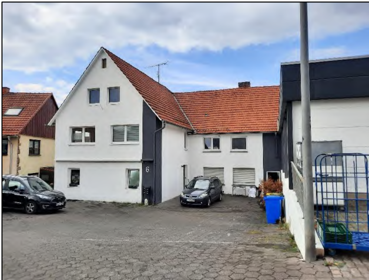
Abb. 1: Straßenansicht Haus Nr. 4
