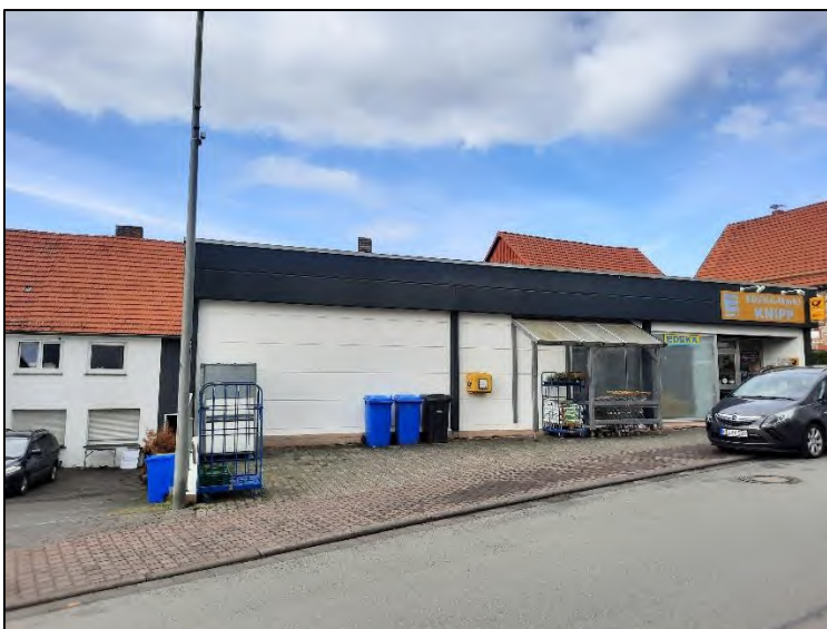
Abb. 2: Straßenansicht Haus Nr. 6
