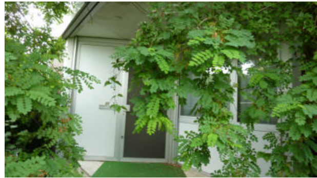
zugewucherter Hauseingangsbereich mit Flachdach
