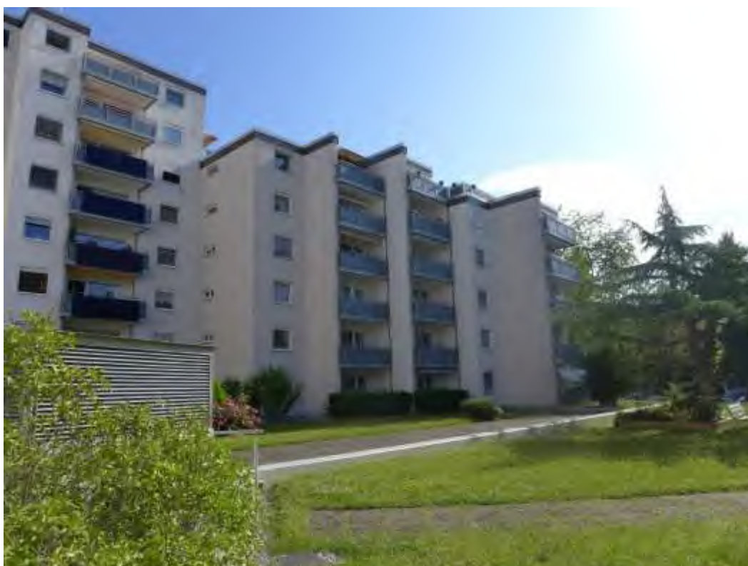
4 Innenhofansicht Bauteil D
