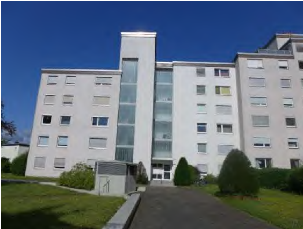
1 Innenhofansicht Bauteil A
