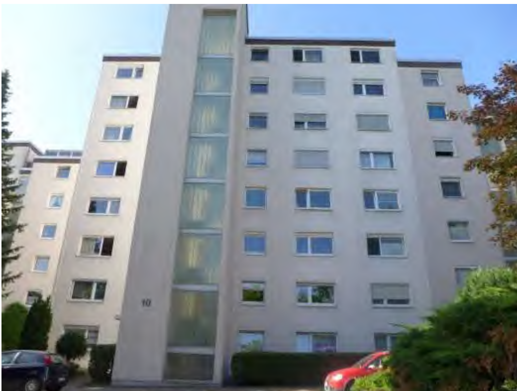
6 Straßenansicht (Nordansicht) Bauteil C (Mittelbau), Kelheimer Straße 10
