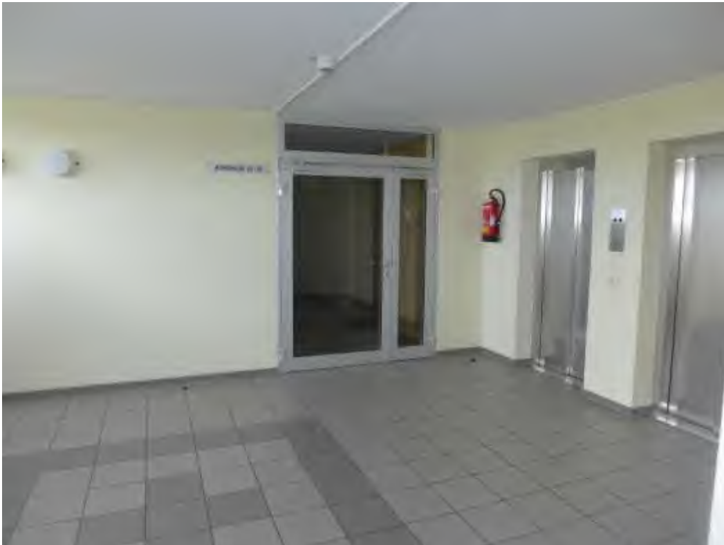
9 Aufzugsvorbereich 5. Aufzugsgeschoss (XII. OG)
