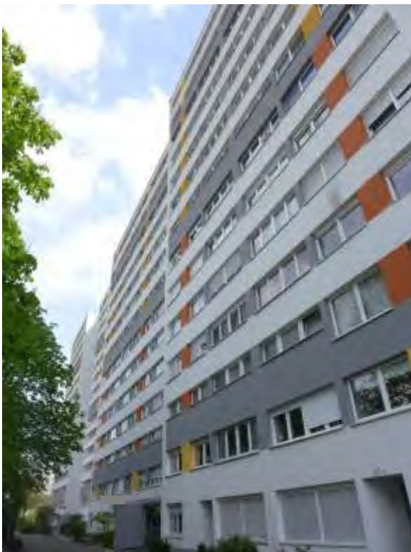
2 a Nordseite Frankfurter Straße 84-86
