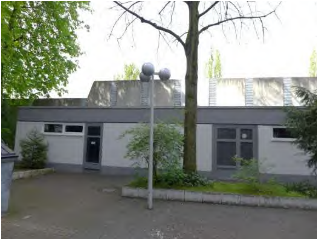
17 Wirtschafts- und Garagengebäude
