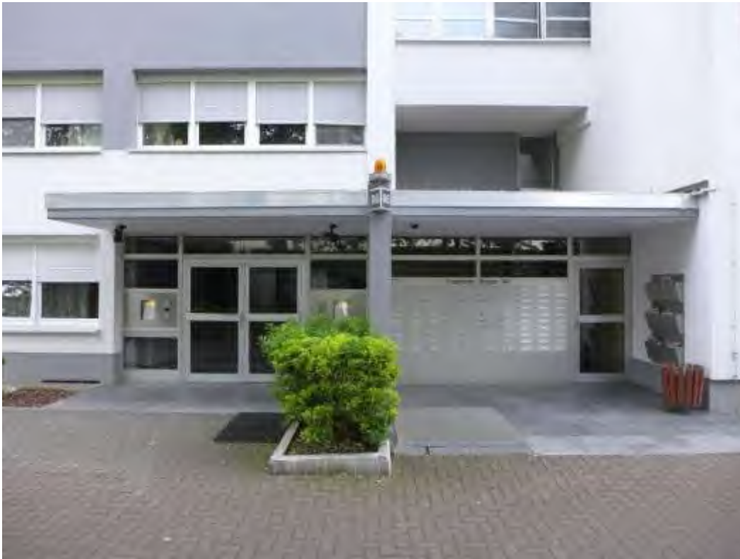
3 Hauseingangsbereich Frankfurter Straße 86
