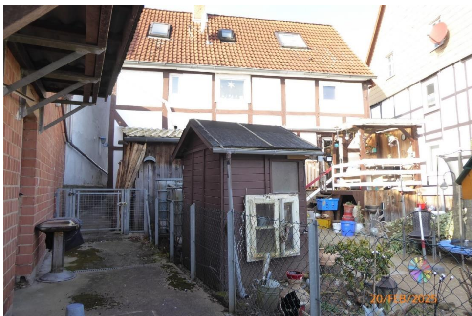
Foto 2: Ansicht aus südöstlicher Richtung
