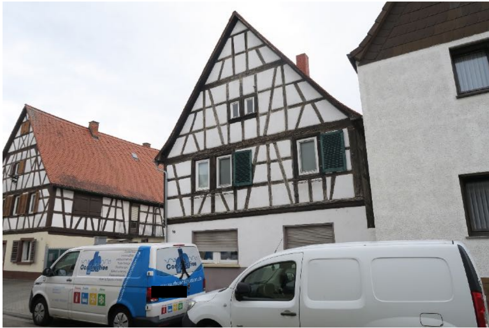
Bild 3: Straßenansicht des Bewertungsobjekts
