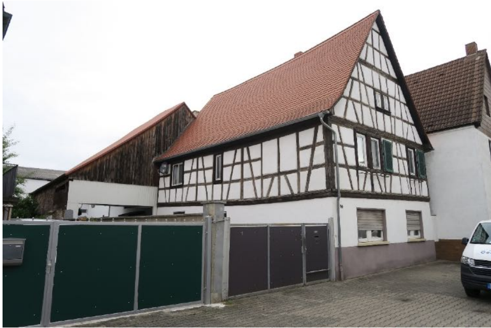
Bild 1: Straßenansicht des Bewertungsobjekts
