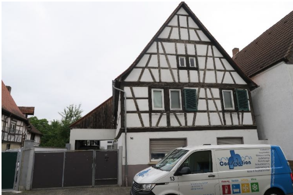
Bild 2: Straßenansicht des Bewertungsobjekts
