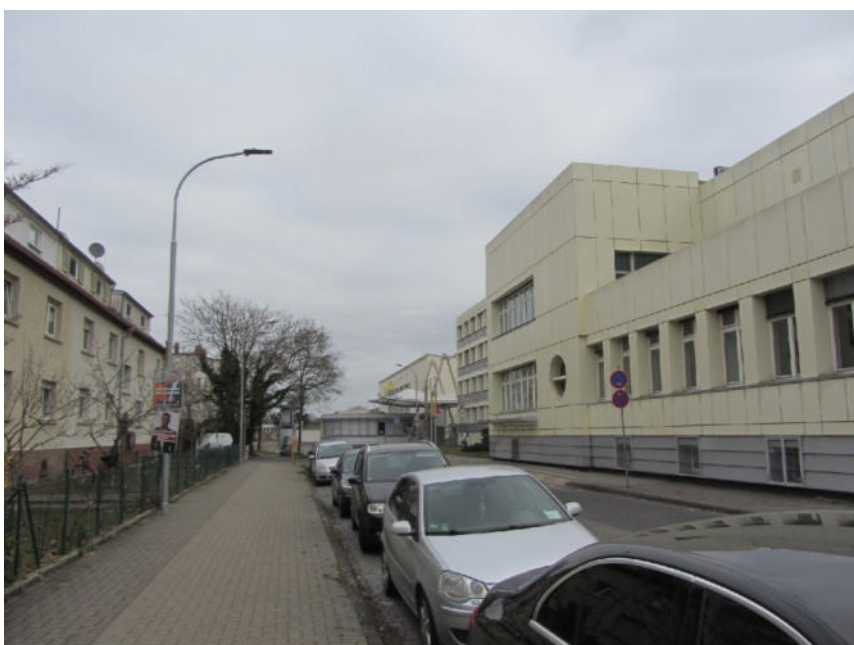
Bild 40: Nachbarbebauung im Straßenverlauf
