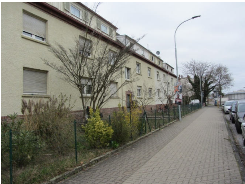
Bild 6: Ansicht Straßenseite, Gebäudekomplex
