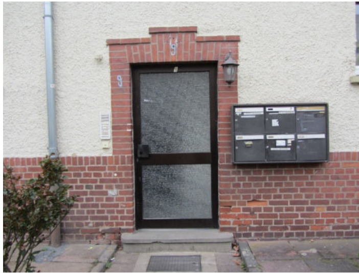
Bild 9: Eingangssituation Gebäude Nr.9
