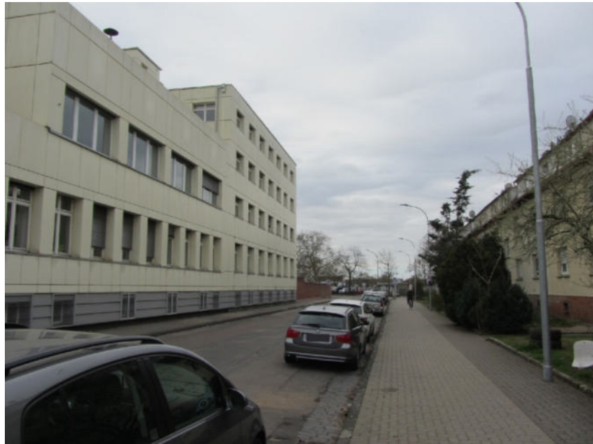
Bild 41: Nachbarbebauung im Straßenverlauf
