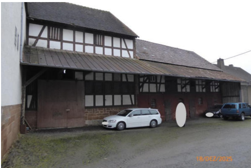
Foto 12: Hofansicht Gebäude 3 (rechts) und Gebäude 4 (links)
