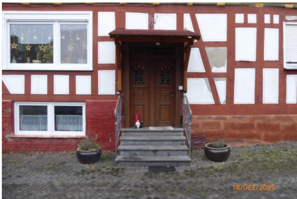
Foto 2: Hofansicht des Hauseingangsbereichs
