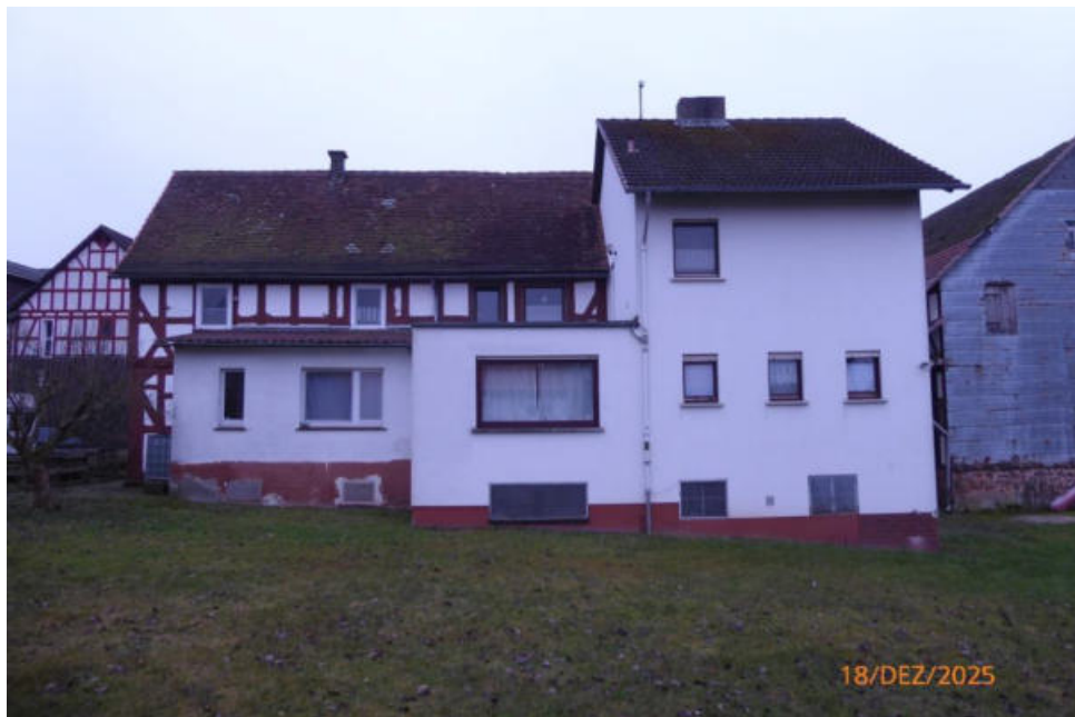
Foto 5: Gartenansicht aus nördlicher Richtung
