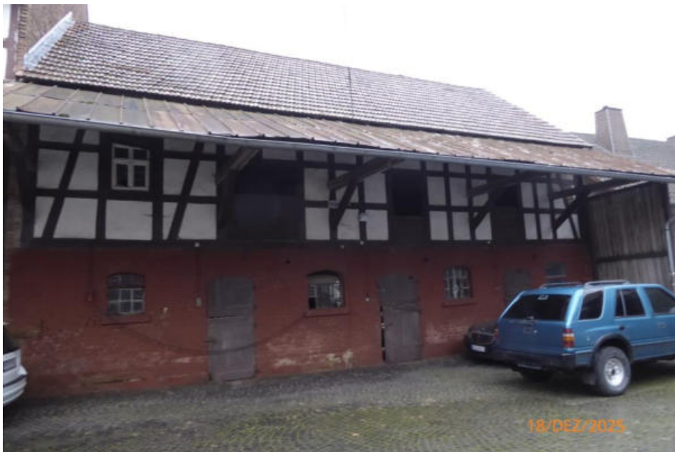
Foto 13: Hofansicht Gebäude 3 - Stall
