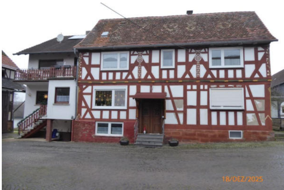
Foto 1: Gebäude 1 - Hofansicht Fachwerkwohnhaus mit Anbau
