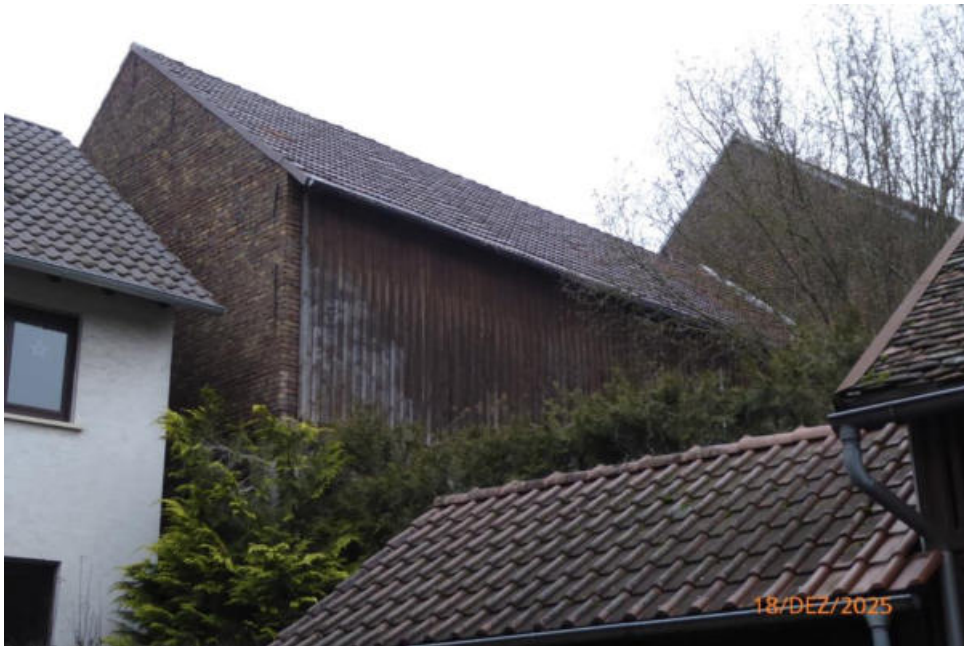
Foto 15: Rückansicht Gebäude 3 und 4 aus südwestlicher Richtung
