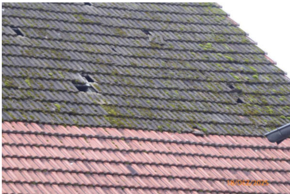
Foto 8: schadhafte Dacheindeckung
