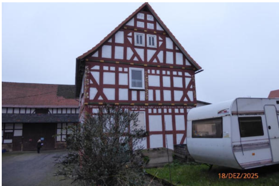
Foto 4: Ansicht Gebäude 1 aus östlicher Richtung
