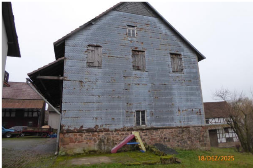
Foto 9: Ansicht Gebäude 2 - Scheune 1 aus nördlicher Richtung
