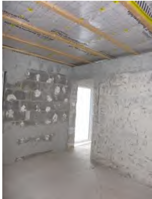
29 b Ausbauzustand 1. OG
