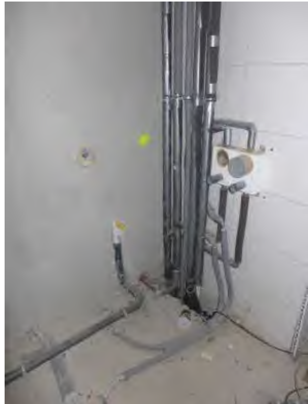
25 b Ausbauzustand Bad 1. OG
