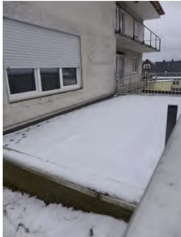
13 b Dach ehemalige Garage
