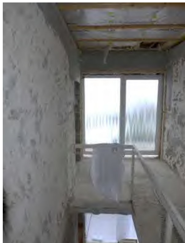
30 b Ausbauzustand 2. OG
