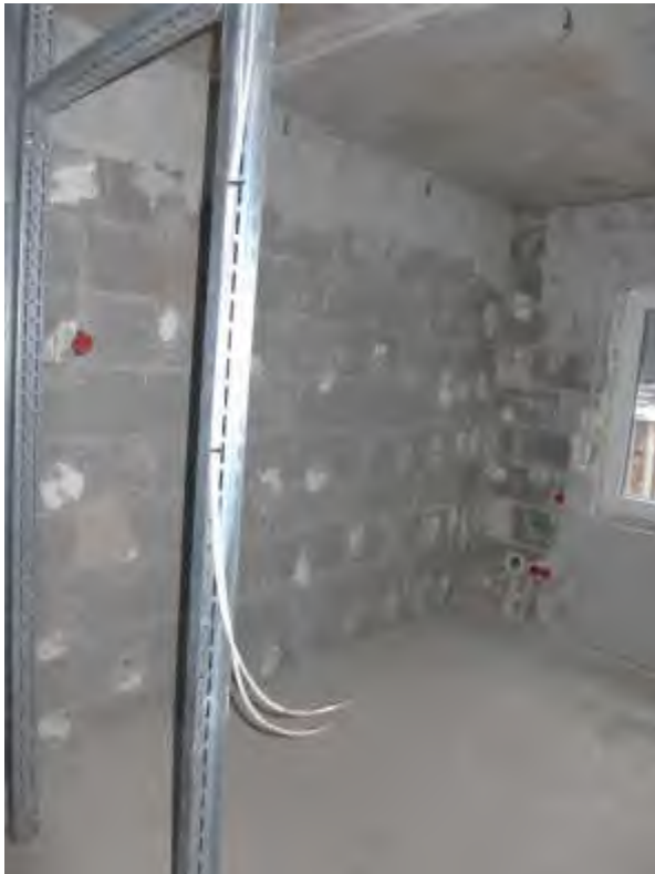
27 a Ausbauzustand 1. OG
