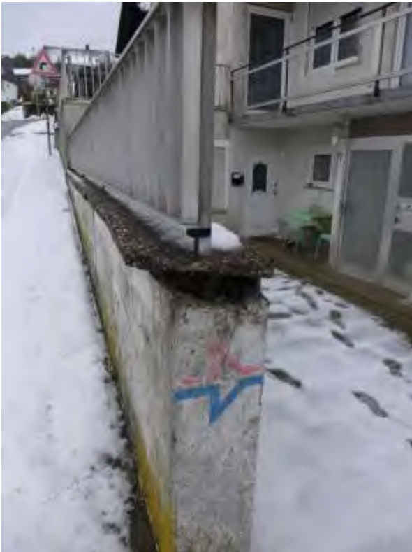
13 a Zustand Einfriedungsmauer
