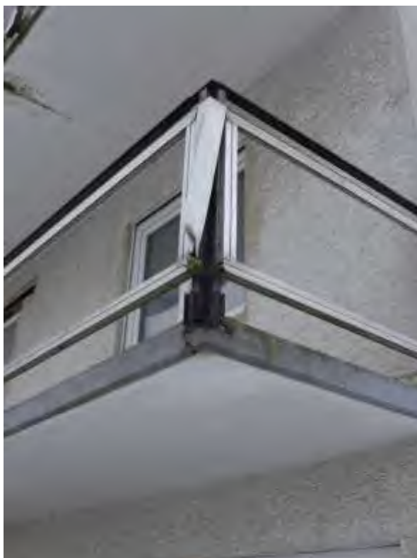
32 a Balkon 1. OG
