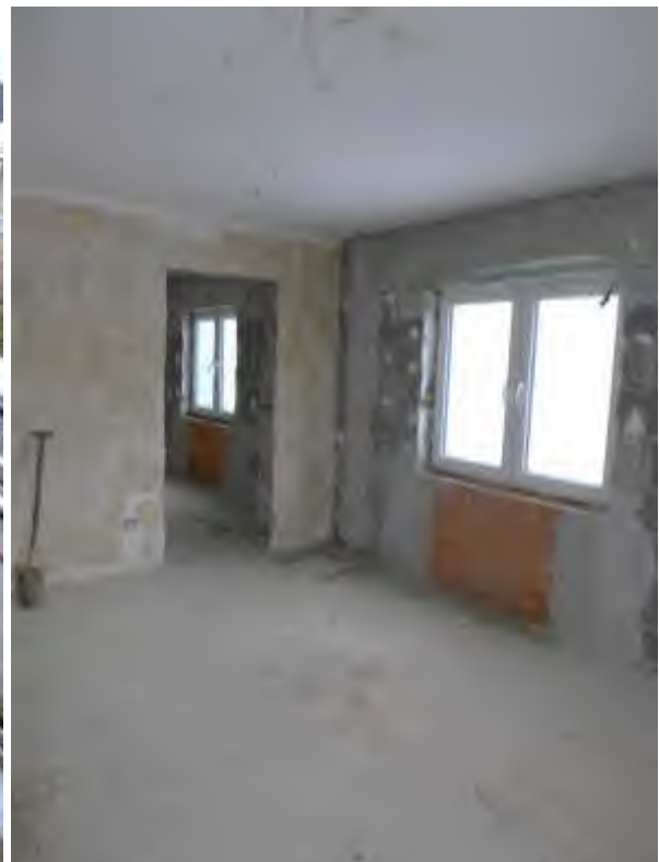
24 b Ausbauzustand 1. OG
