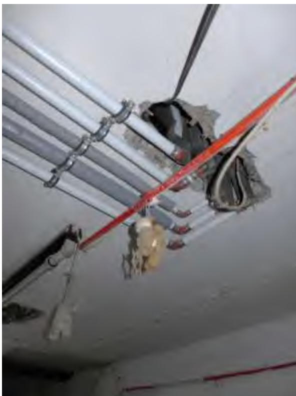
20 a teilerneuerte Leitungen KG/EG
