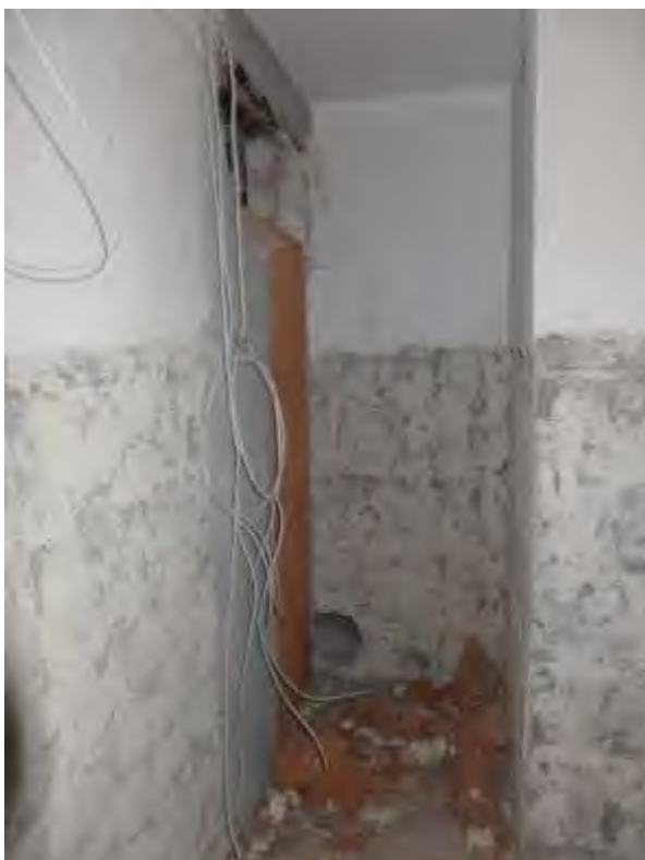
28 a Ausbauzustand 1. OG
