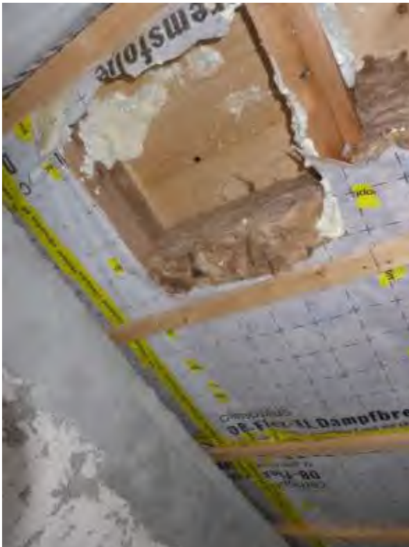
31 a Dämmung zum Dach 2. OG
