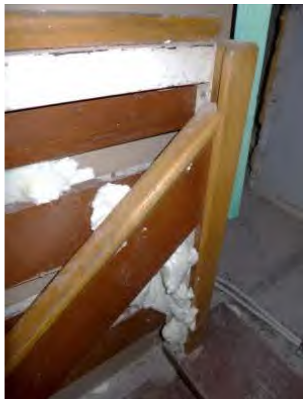
22 b angefangene Baumaßnahmen zur Abtrennung des Treppenhauses
