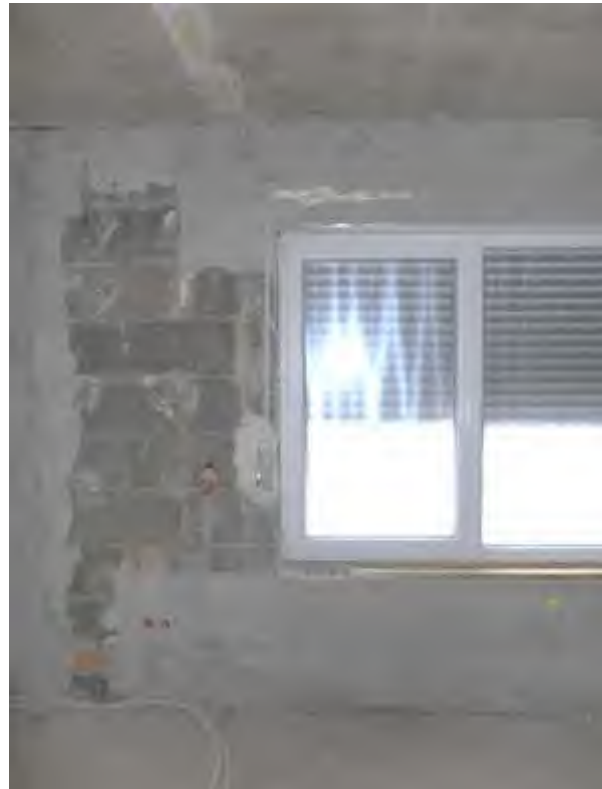
27 b Ausbauzustand 1. OG
