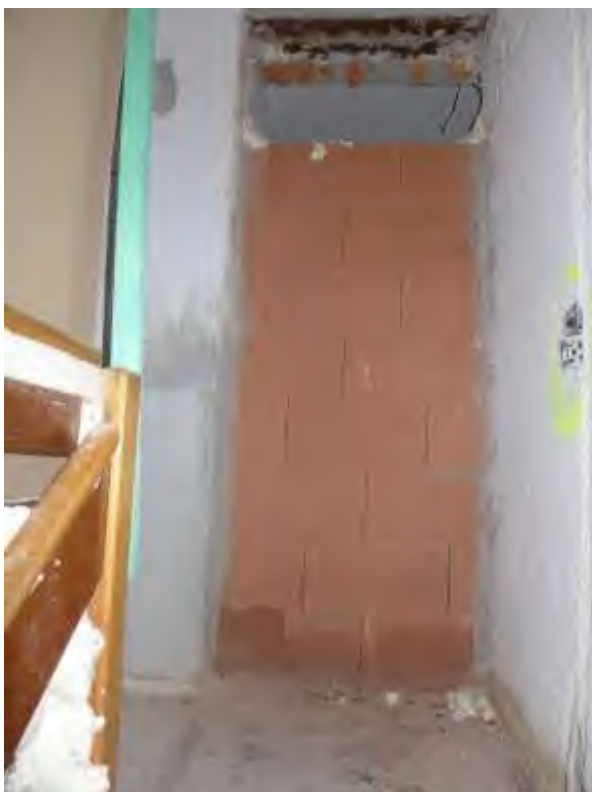
22 a Ausbauzustand 1. OG
