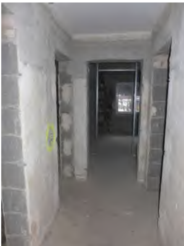
26 a Ausbauzustand 1. OG
