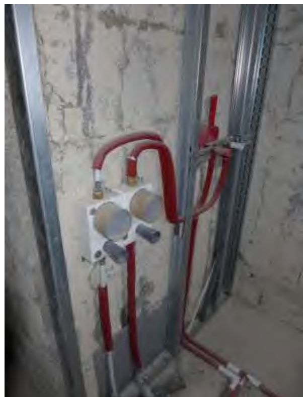
28 b Ausbauzustand 1. OG
