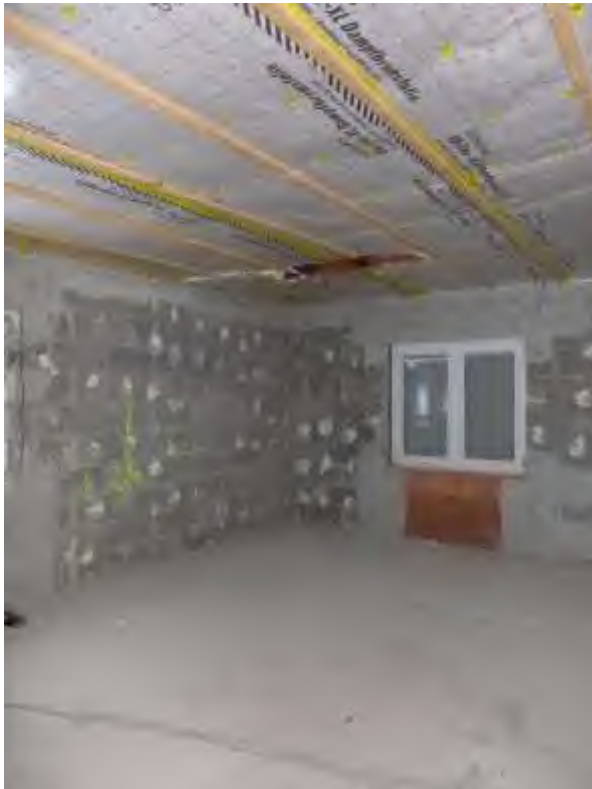
29 a Ausbauzustand 1. OG
