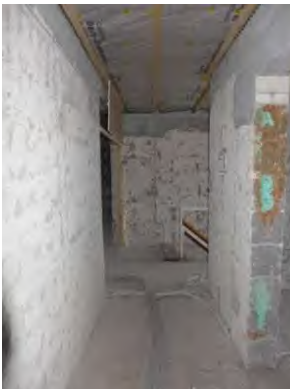
30 a Ausbauzustand 2. OG
