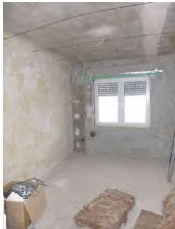
26 b Ausbauzustand 1. OG
