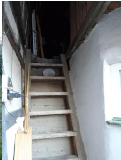
Treppe zum Heuboden
