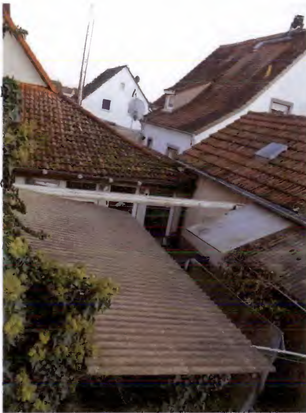
Innenbereich/Terrasse – Durchgang zum
