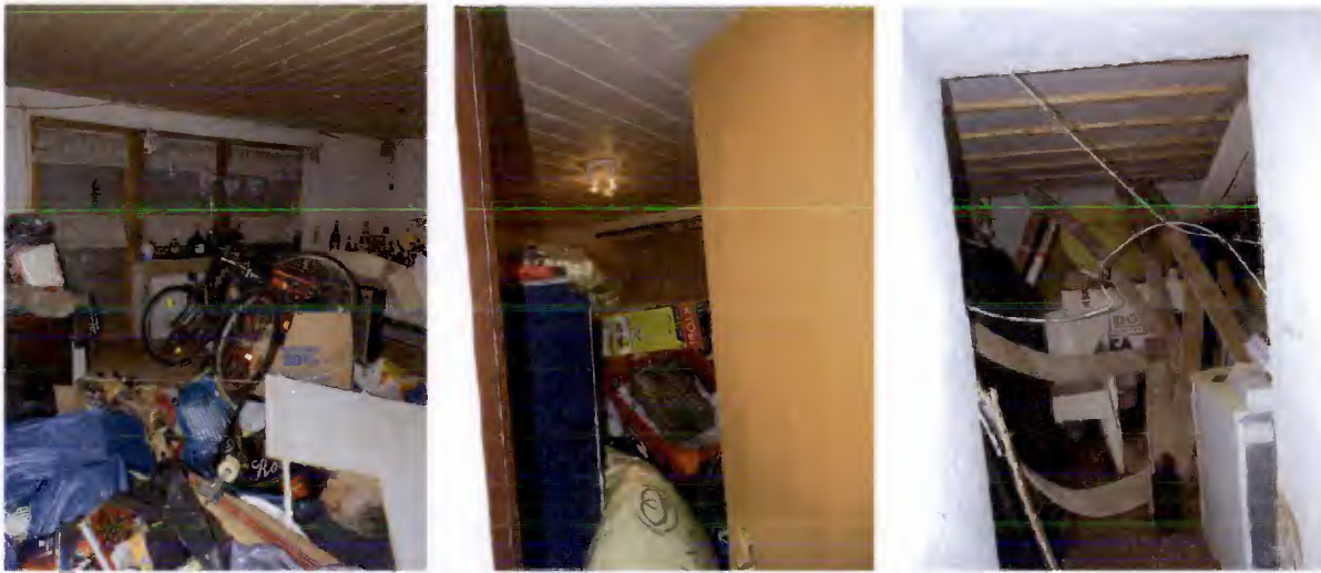
Vermüllter Kellerbereich – hinteres Gebäude
