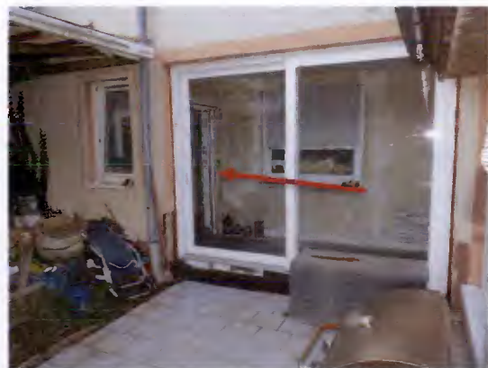
Eingangsbereich – hinteres Gebäude
