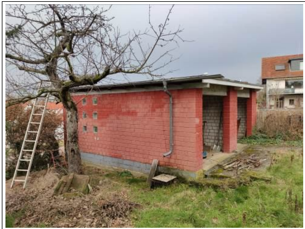
Blick auf die Garage von Süden
