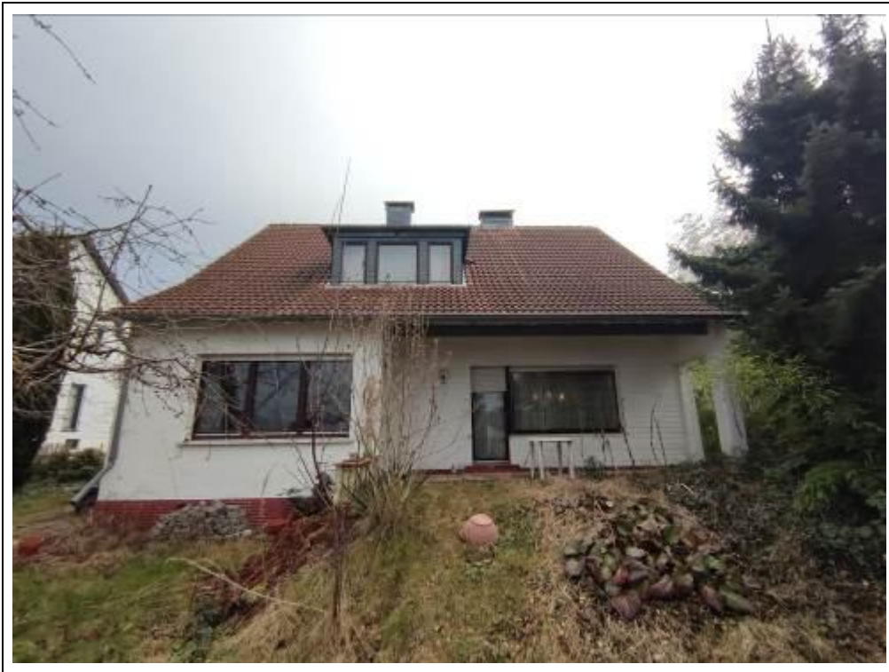
Blick auf das Wohnhaus von Nordwesten
