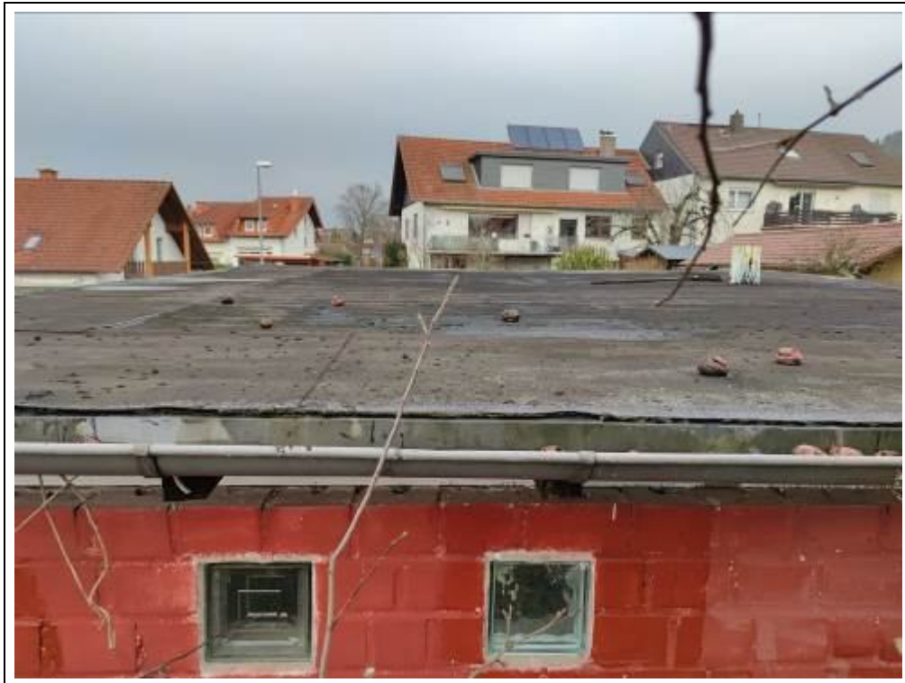
Blick auf die Dacheindeckung mit Bitumenschweißbahnen
