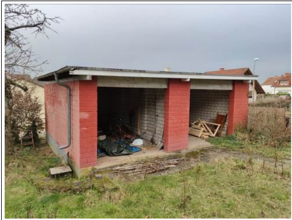
Blick auf die Garage von Süden
