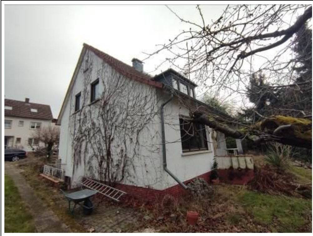
Blick auf das Wohnhaus von Norden
