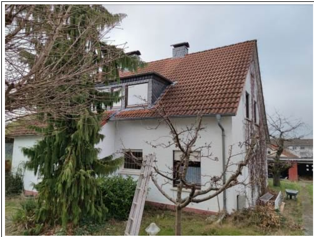
Blick auf das Wohnhaus von Osten
