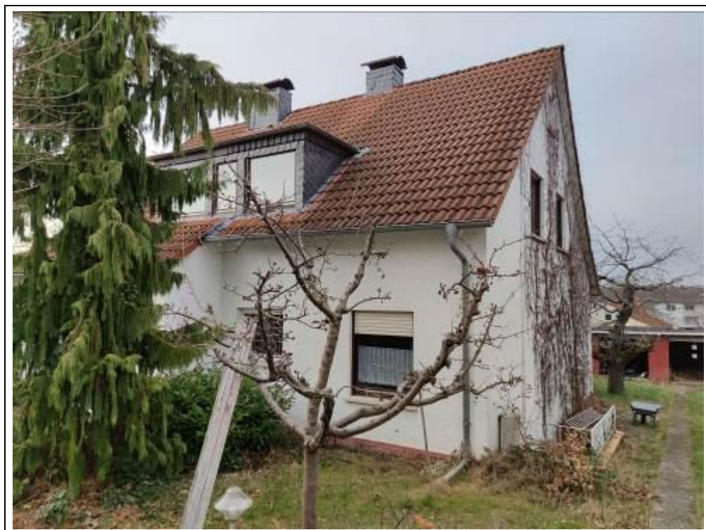
Blick auf das Wohnhaus von Südosten
