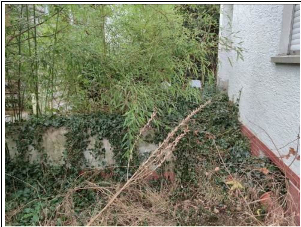
Blick auf eine kleine Betonstützmauer im Bereich der Terrasse
