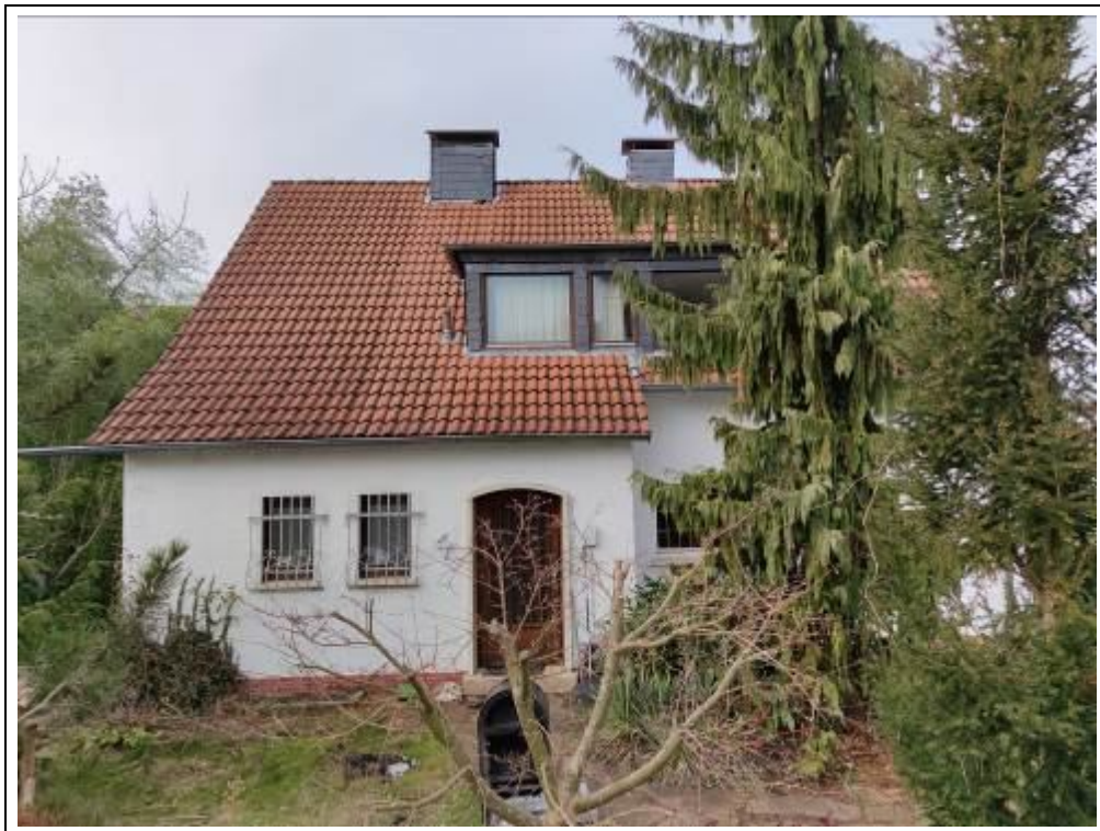
Blick auf das Wohnhaus von Südosten
