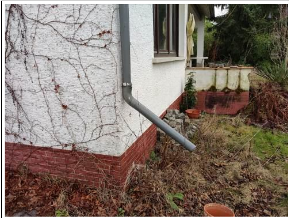
Blick auf die nicht angeschlossenen Regenfallrohre
