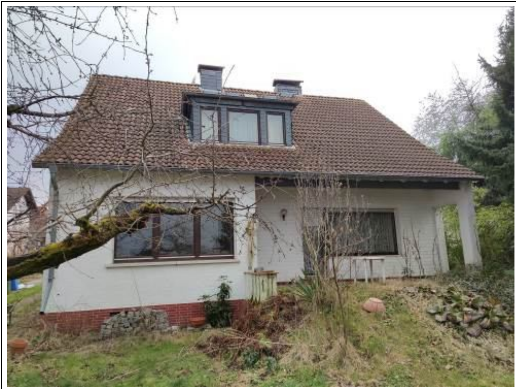
Blick auf das Wohnhaus von Nordwesten
