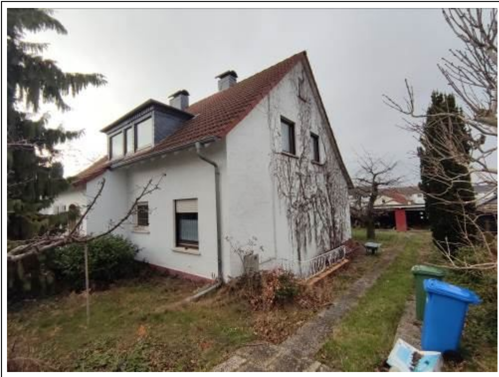
Blick auf das Wohnhaus von Osten
