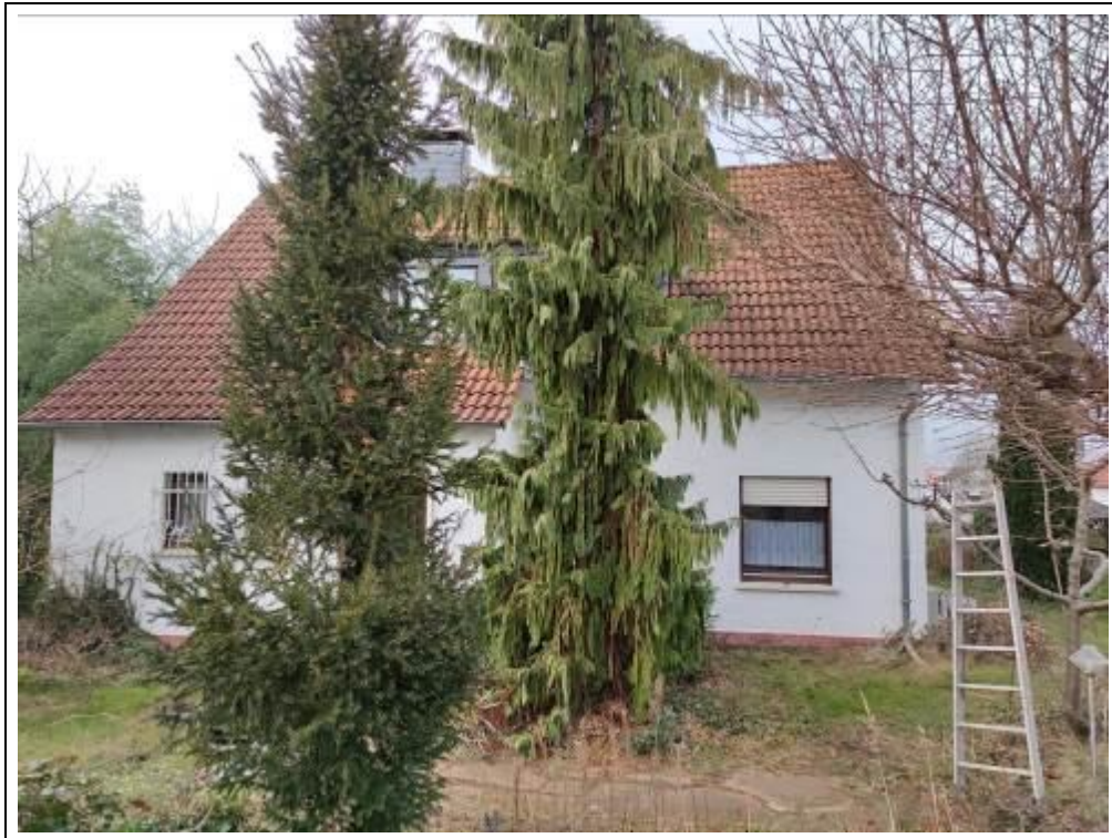
Blick auf das Wohnhaus von Südosten
