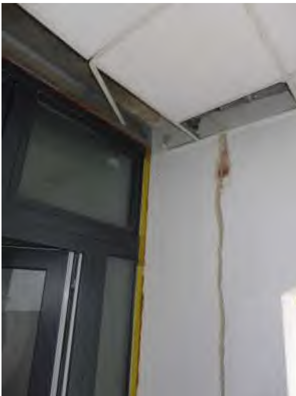
32 a nicht fertiggestellter Eingangsbereich
