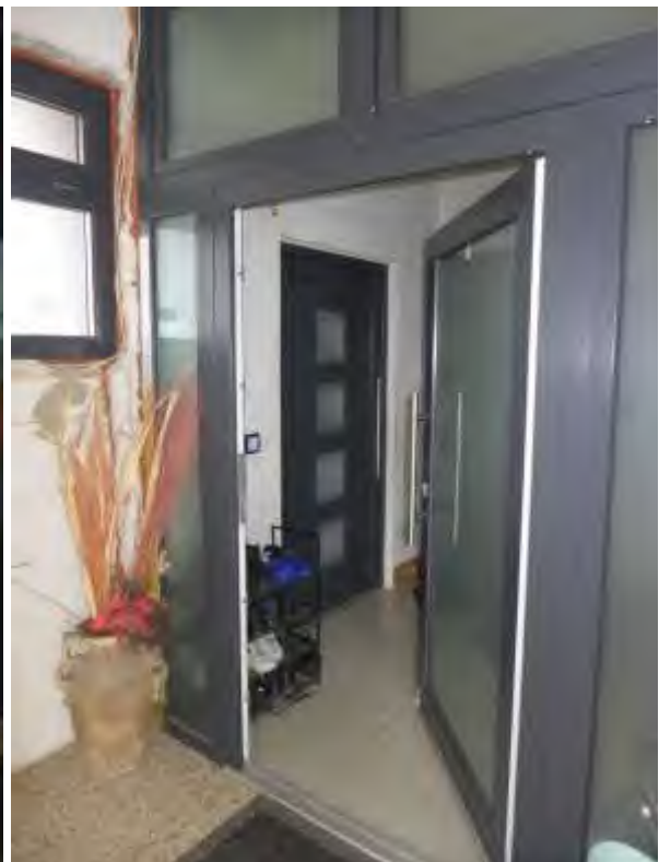
20 b Zwischentür Eingang Erdgeschoss
