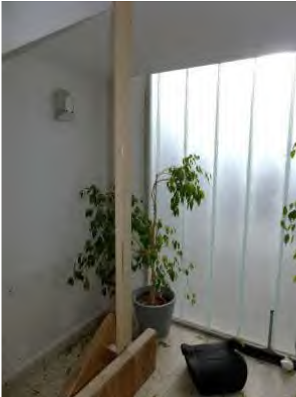
23 a Fenster Treppenhaus
