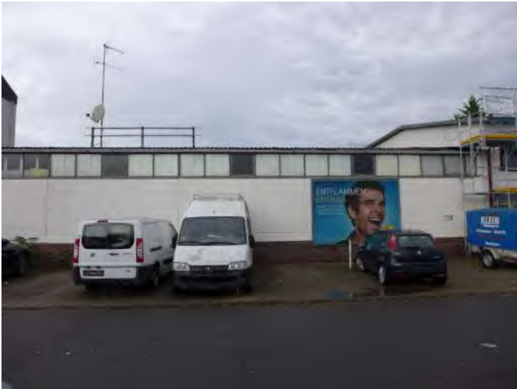
5 Seitenansicht Halle (Südostansicht)
