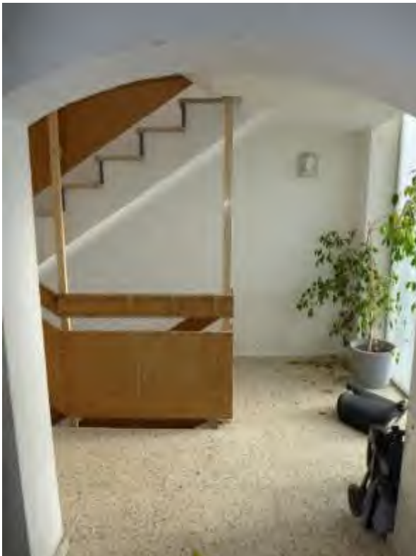
21 a Treppenhaus Erdgeschoss
