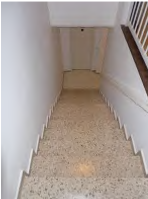
28 a Treppe zum Kellergeschoss
