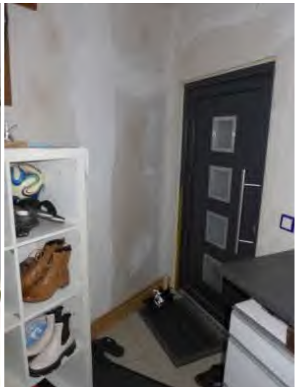
32 b nicht fertiggestellter Zwischenbereich
