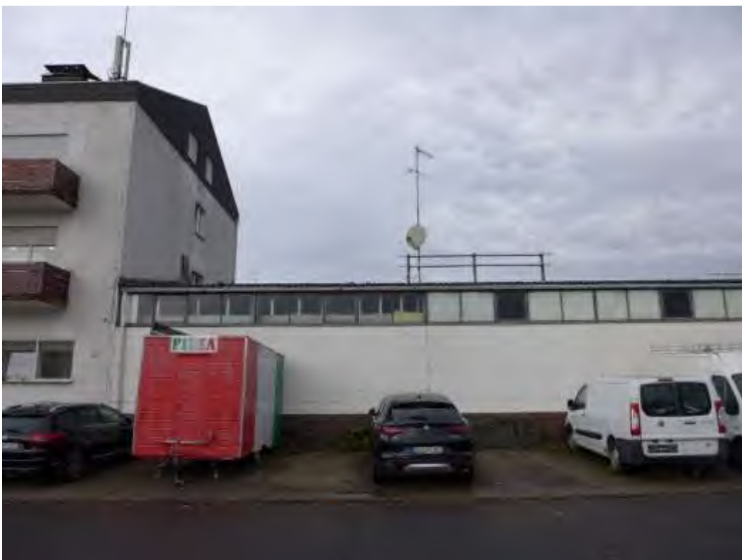
4 Seitenansicht Halle (Südostansicht)
