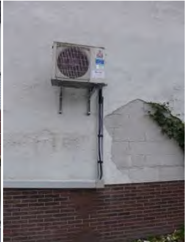
33 b Fassadenschäden
