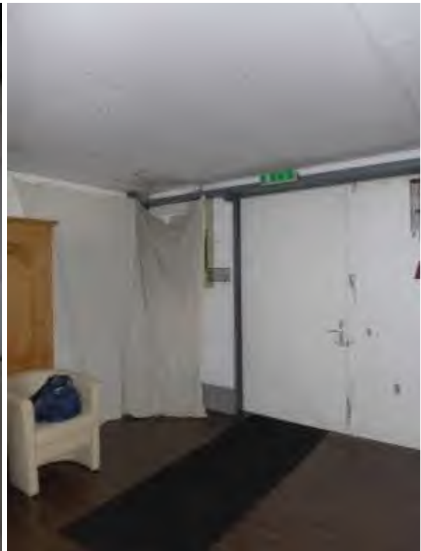
27 b Innenbereich Halle
