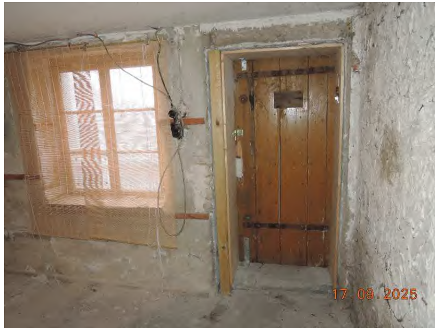
Bild 19: Kellerraum mit Zugang zum Garten
