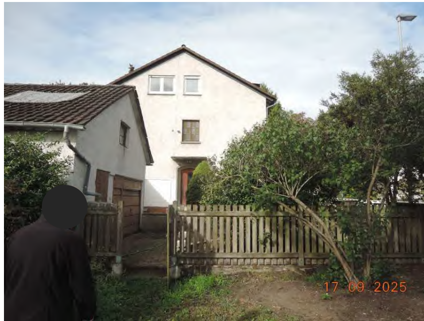
Bild 1: Giebelansicht des Wohnhauses und des Garagengebäudes
