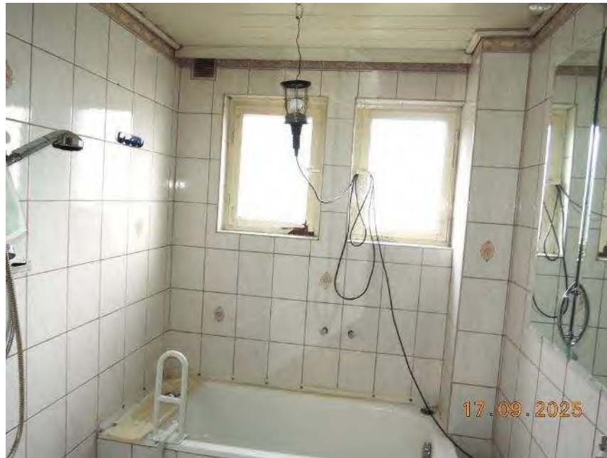
Bild 3: Bad der Wohnung im Erdgeschoss
