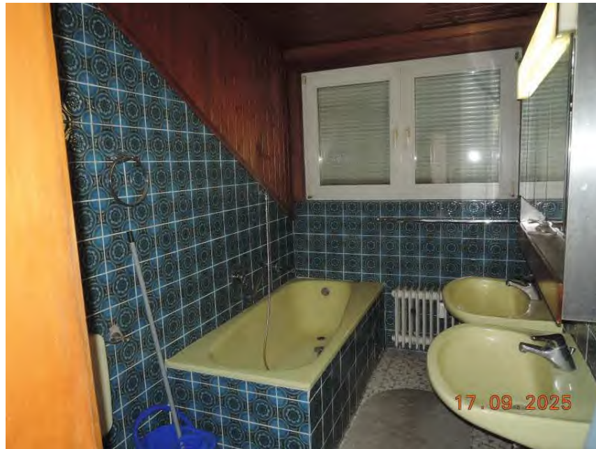
Bild 15: Bad im Dachgeschoss
