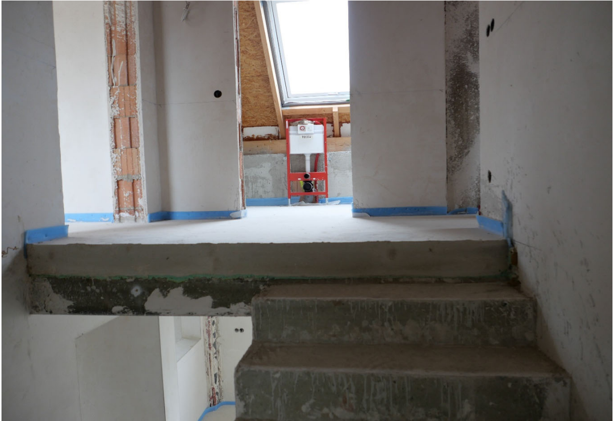
Foto 07 (Treppenaufgang ins Dachgeschoss)
