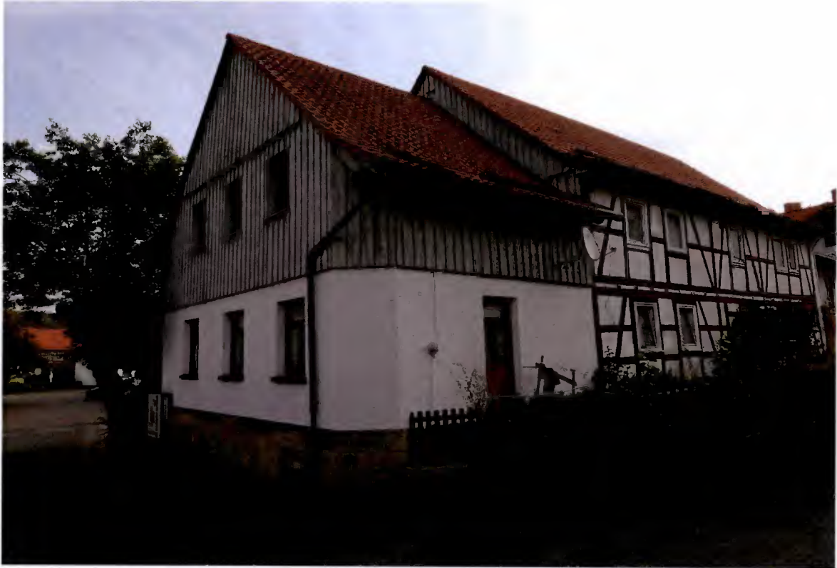
Foto 07 (Anbau Wohnhaus und Fachwerkhaus)
