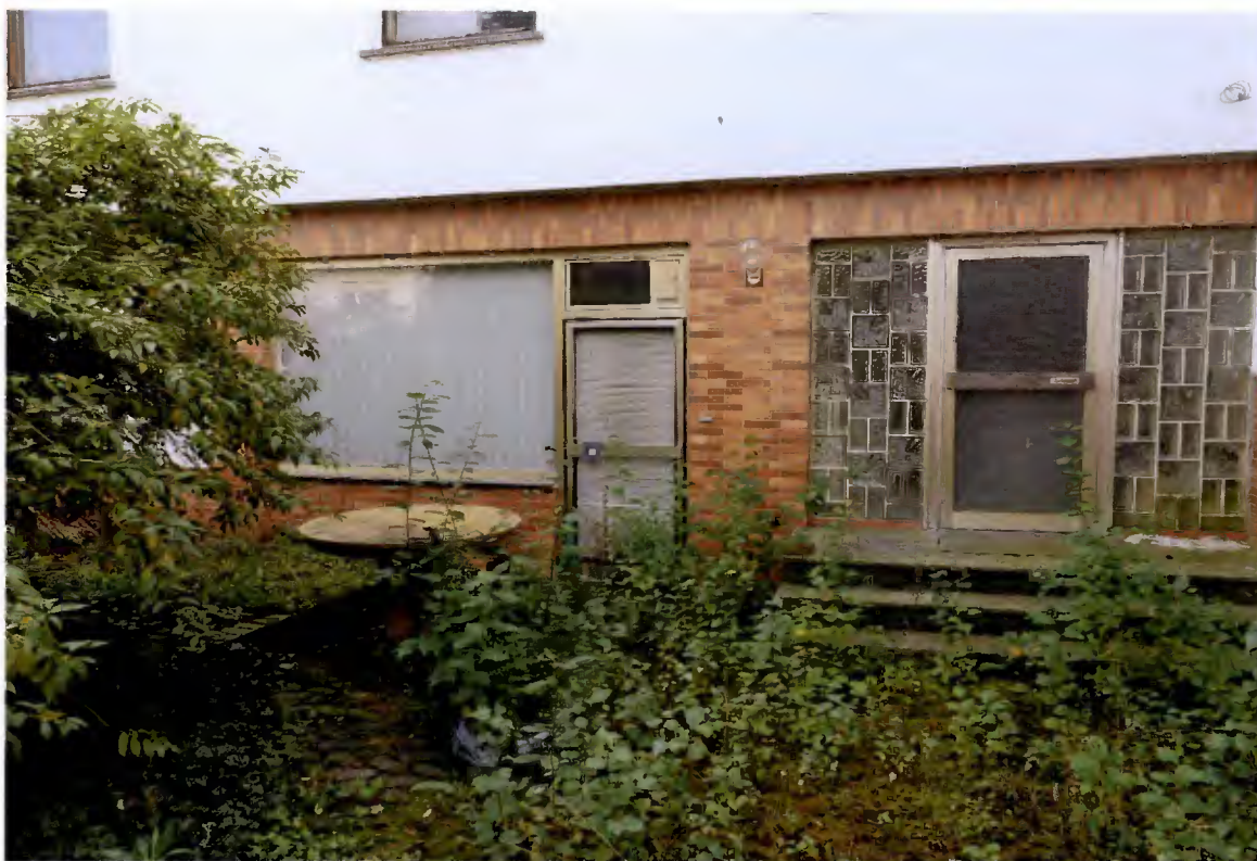
Foto 03 (Eingang Gewerbe Kellergeschoss)
