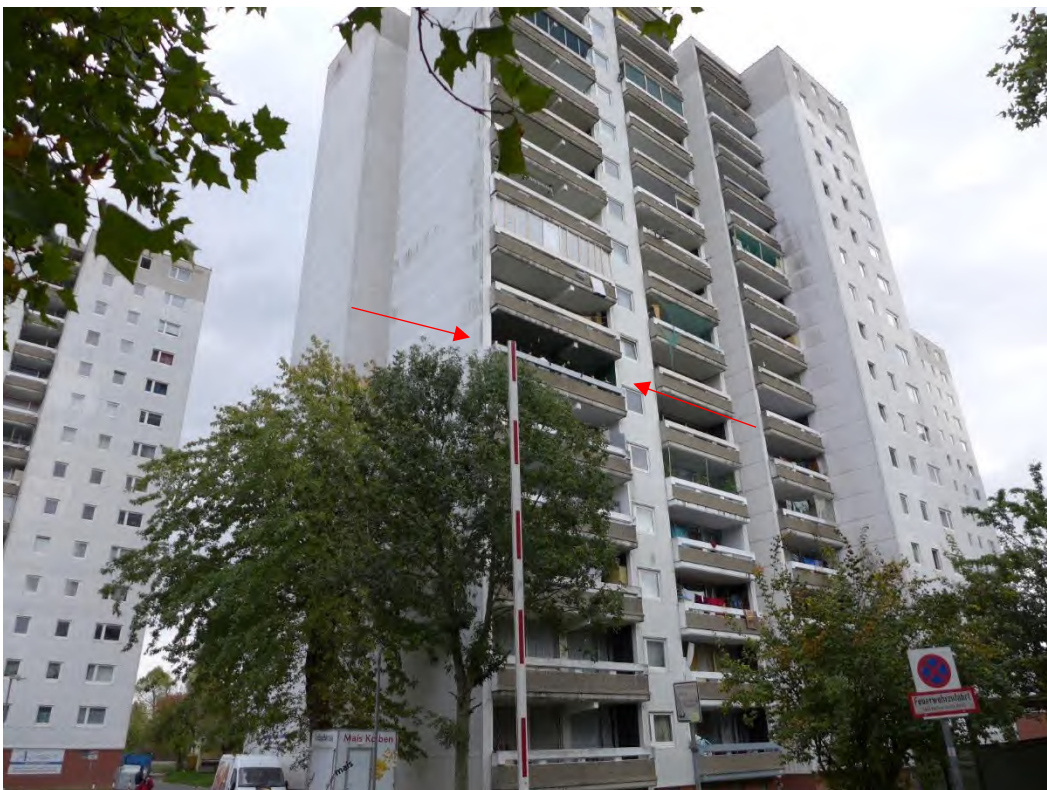
2 Straßenansicht (Nordwestansicht) Gebäude Rohrbrunner Weg 2-4, Lage Wohnung Nr. 422
