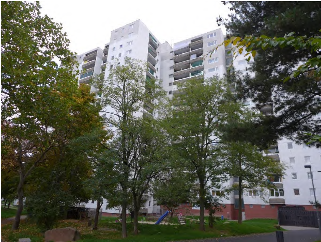
1 Straßenansicht (Westansicht) Gebäude Rohrbrunner Weg 2-4
