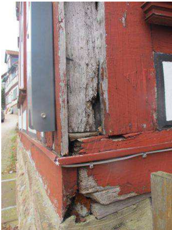
Schäden Fachwerkkonstruktion
