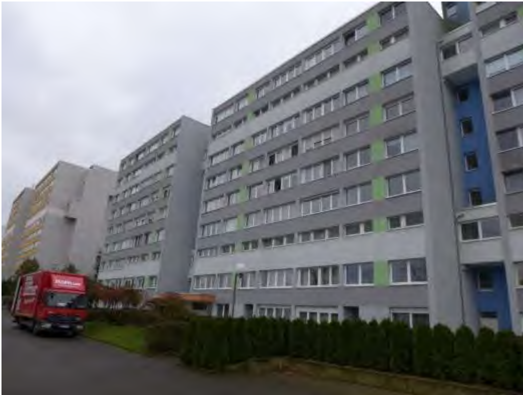
13 Nordseite Haus Nr. 4 und 2
