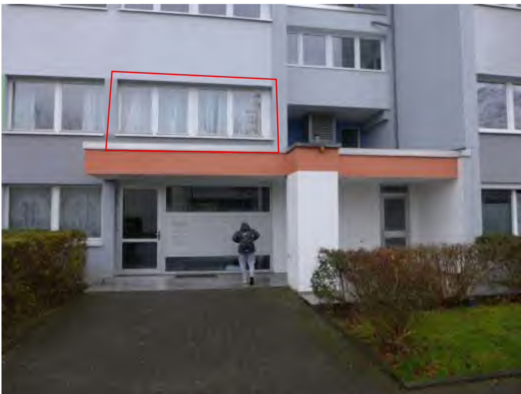
18 Eingangsbereich Haus Nr. 2, Bewertungsobjekt markiert
