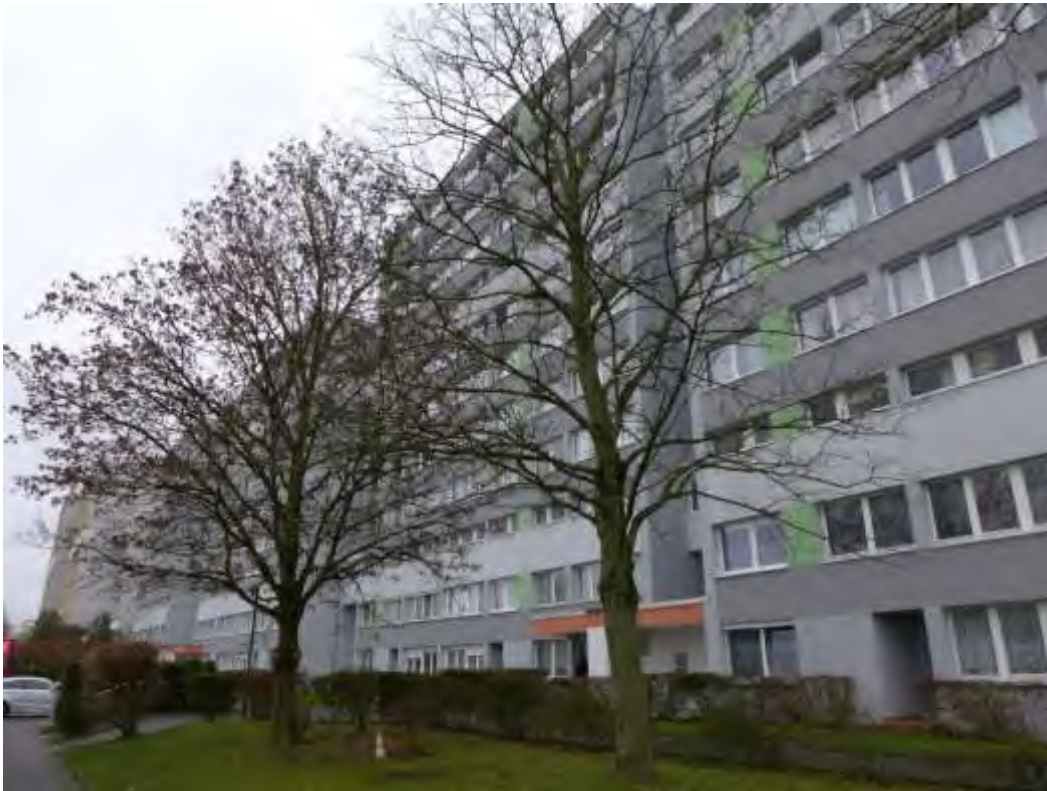
11 Nordseite Haus Nr. 4 und 2
