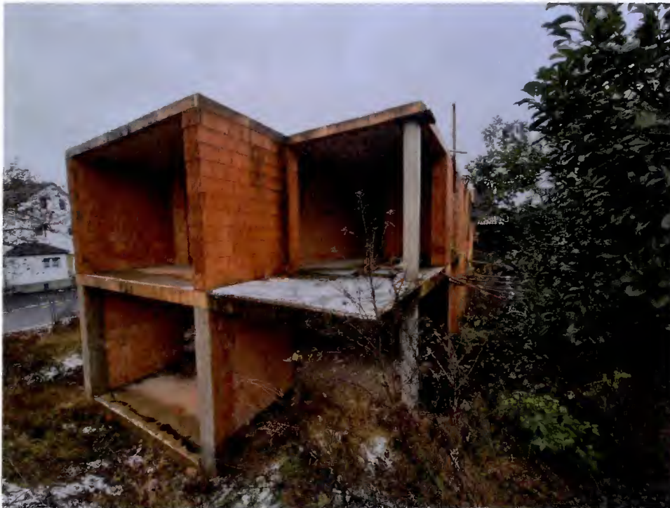
Beschreibung:03 Rohbau hinten
