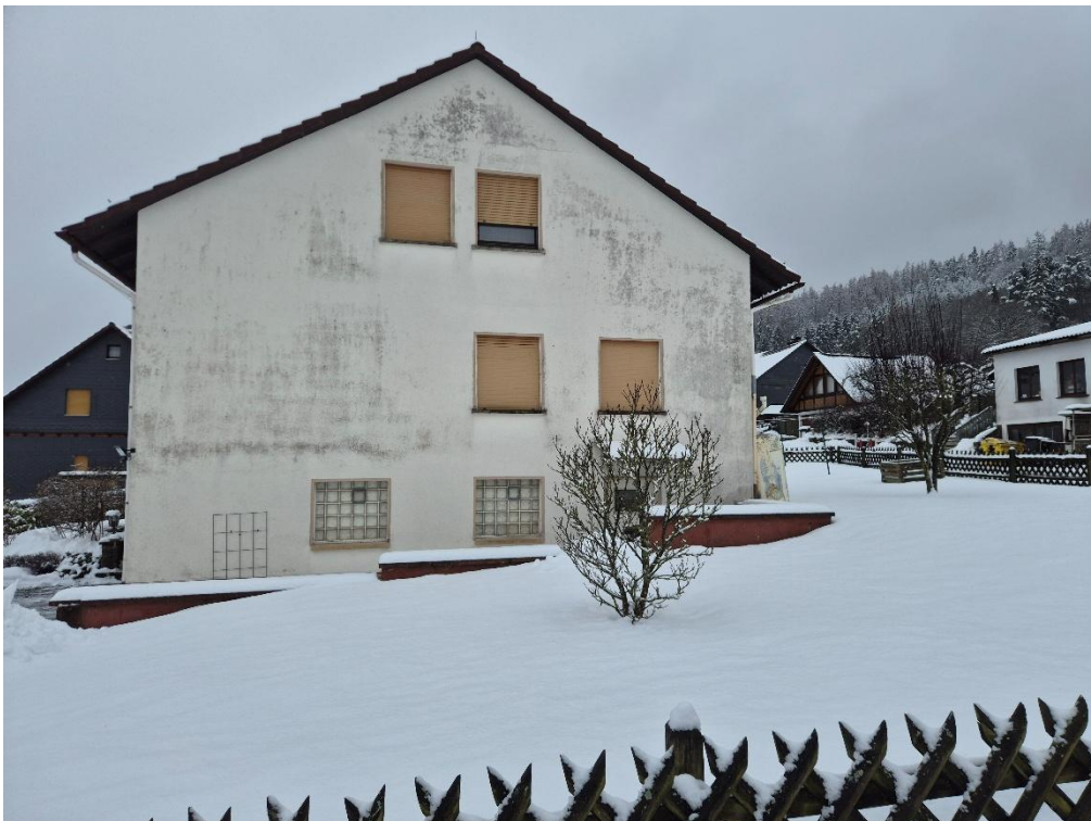
Beschreibung:02 Wohngebäude straßenseitig
