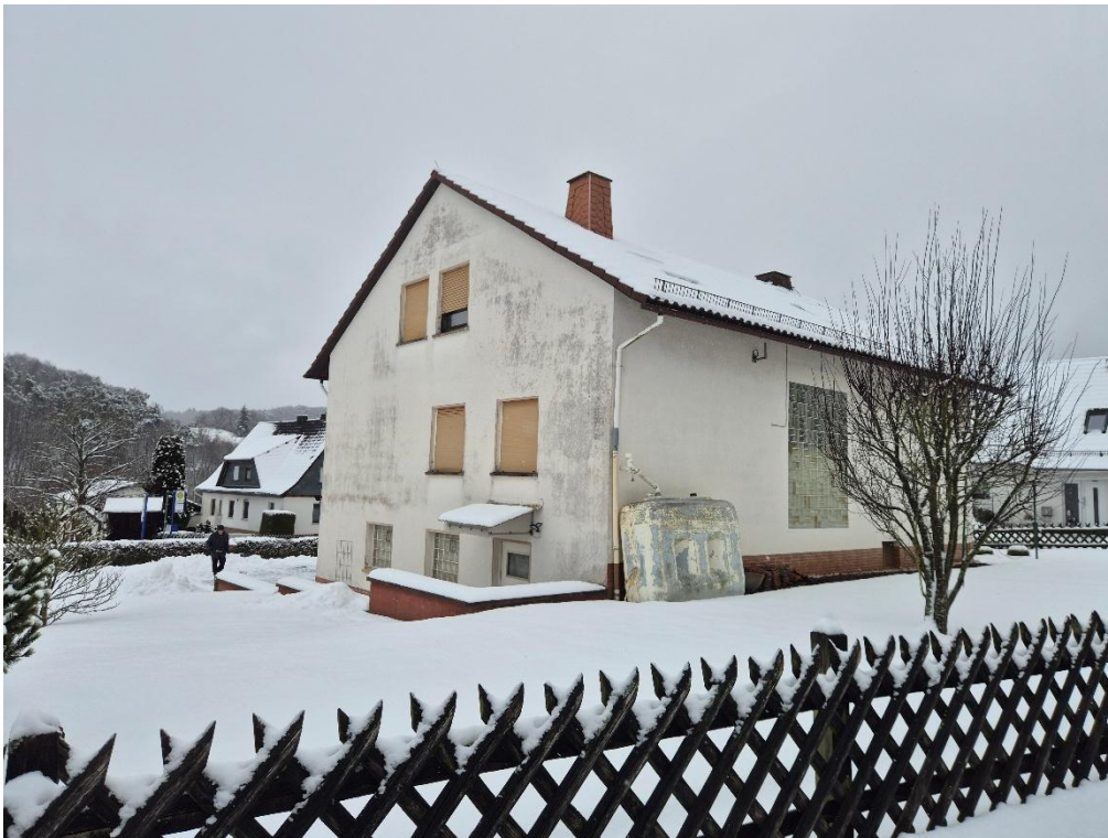
Beschreibung:03 Wohngebäude straßenseitig
