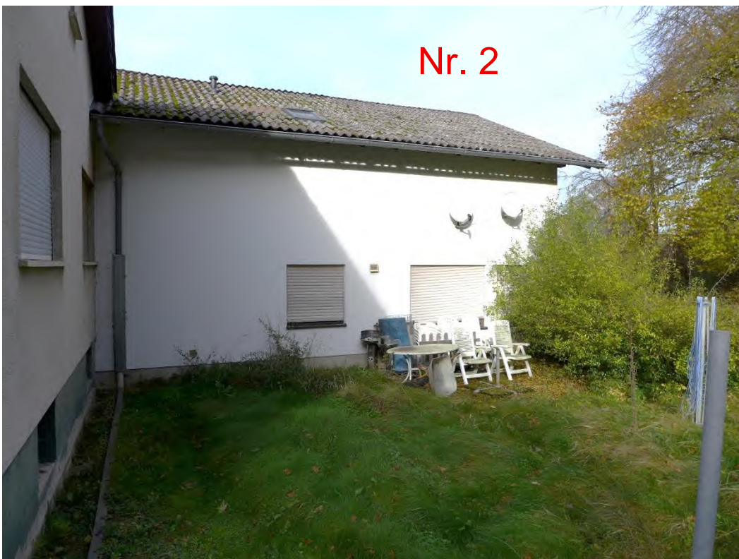
10 Gartenseite, Südansicht, überwucherte Terrasse
