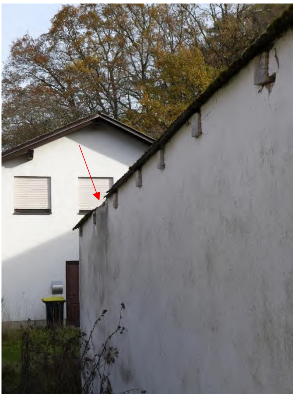
14 a Zustand Garagenfassade, Dach
