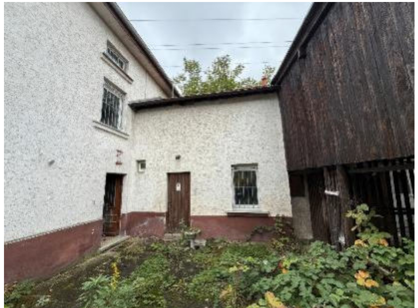
Foto 4 des SV: Ansicht von Osten
