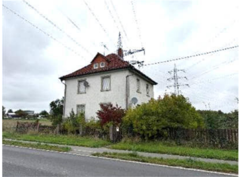
Foto 1 des SV: Anwesen Raunheimer Straße 49; Ansicht von Süden, von der Straße Raunheimer Straße
