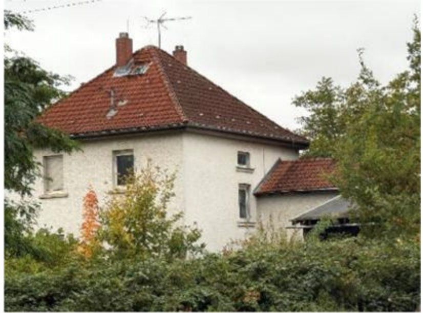
Foto 3 des SV: Ansicht von Osten
