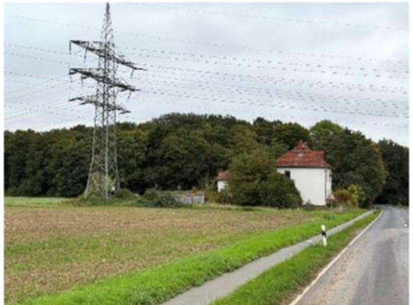
Foto 2 des SV: Ansicht von Westen
