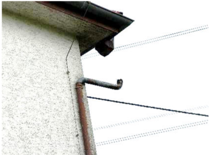
Abb. 2: Foto des SV; z.T. Regenwasserfallrohr ohne Anschluss an die Dachrinne
