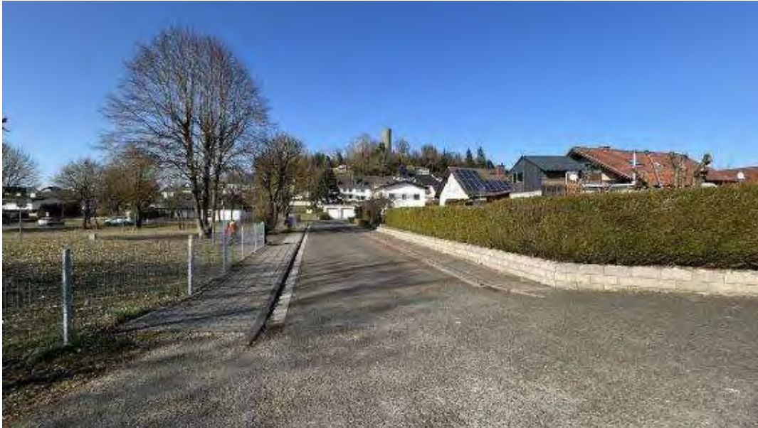
Bild A1 Blick in die Erschließungsstraße
