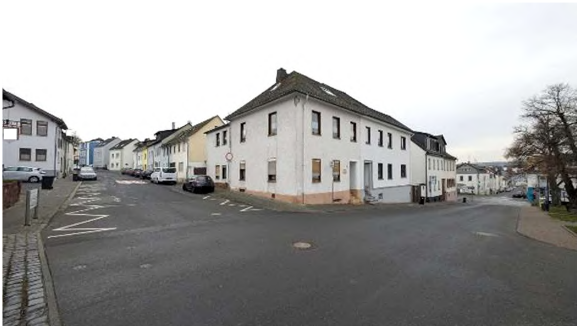
Bild A2 Blick in die Erschließungsstraße / Umfeld
