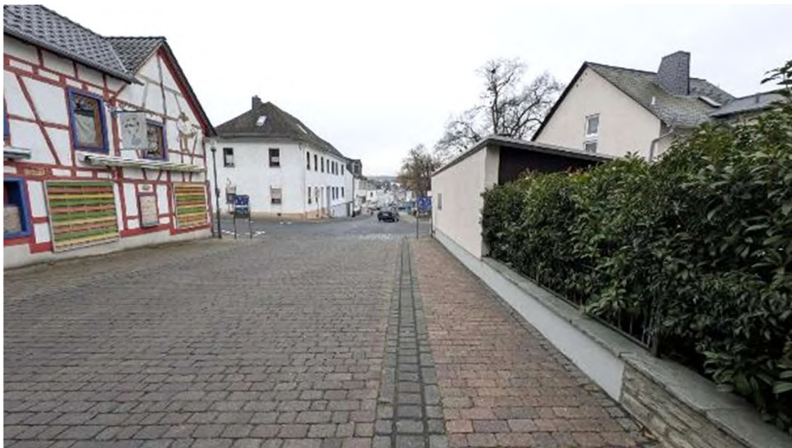
Bild A4 Blick in die Erschließungsstraße / Umfeld
