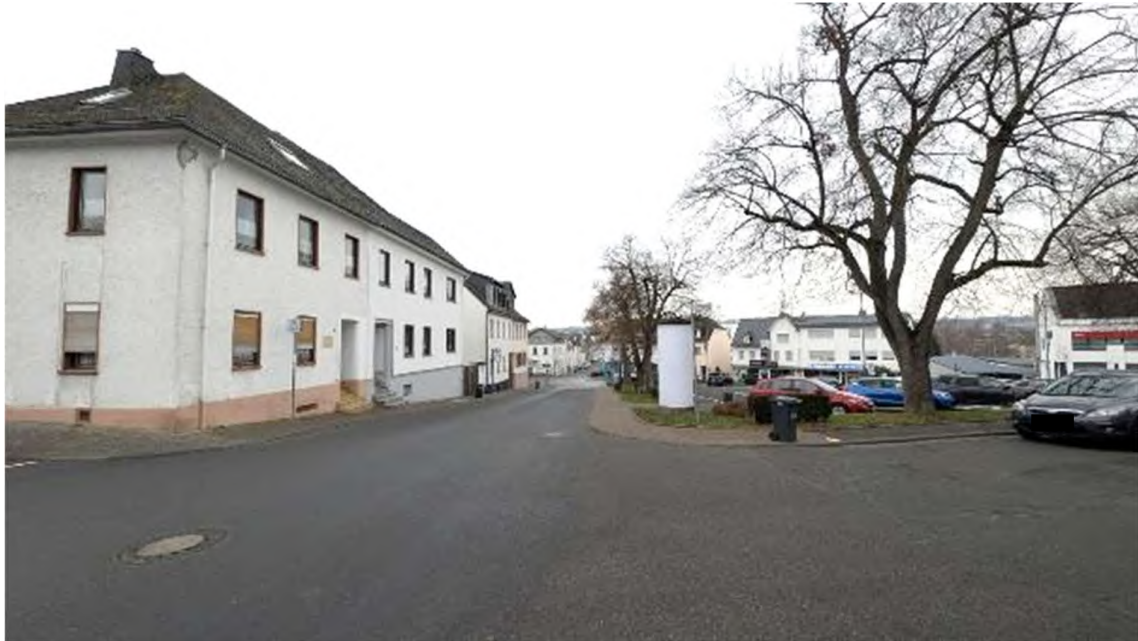
Bild A1 Blick in die Erschließungsstraße / Umfeld
