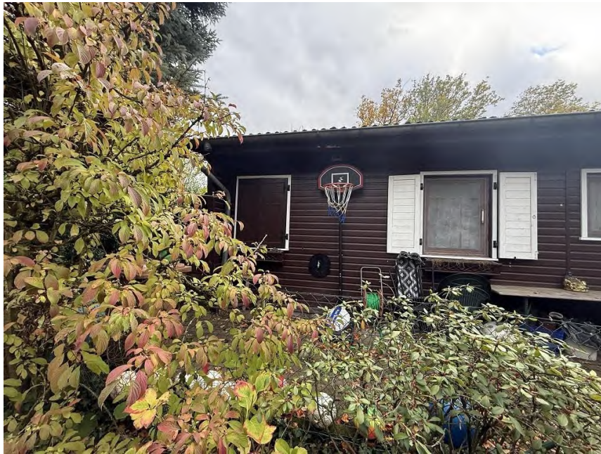
Längsansicht des Gebäudes vom Erschließungsweg betrachtet
