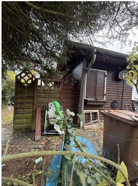
südöstliches Ende des Gebäudes
