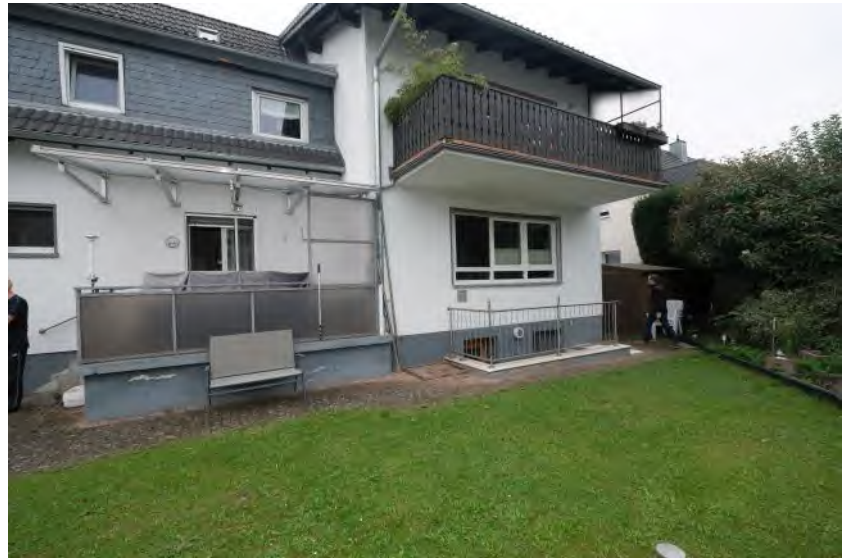
Ostfassade zur Gartenseite mit Terrasse im Erdgeschoss und Balkon im Dachgeschoss.
