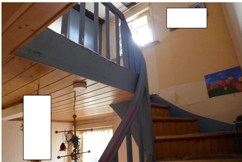
Bild_22_“Holztreppe zum Obergeschoss”
