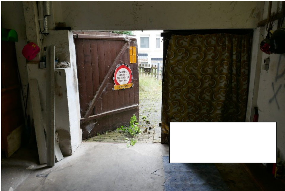
Bild_15_“Holztor zum „Gartengeräteraum“/Lager,“
