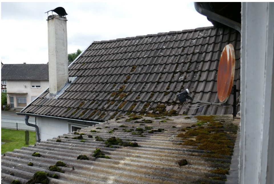
Bild_04_Dacheindeckung südlicher Anbau (Kein Zugang zu diesem DG möglich)
