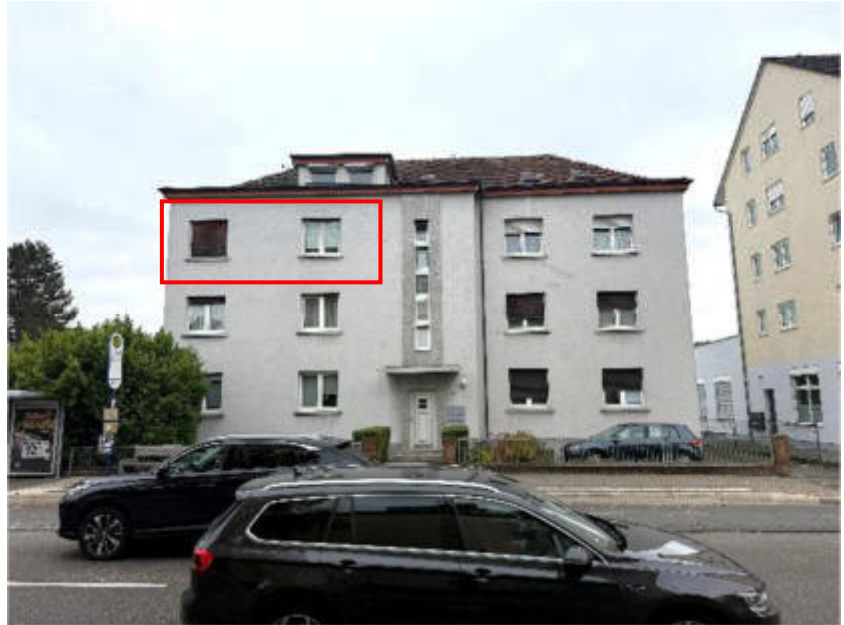
Foto 1 des SV: Bruchköbeler Landstraße 45; Ansicht von Osten, Eingangsseite; Rotmarkierung d.d. SV: Wohnung Nr. 6
