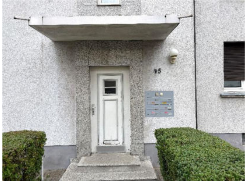
Foto 5 des SV: Gebäudeeingang
