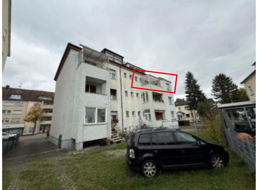
Foto 3 des SV: Bruchköbeler Landstraße 45; Gebäuderückseite und Hof mit Pkw-Stellplätzen; Rotmarkierung d.d. SV: Sondereigentum Nr. 6;
