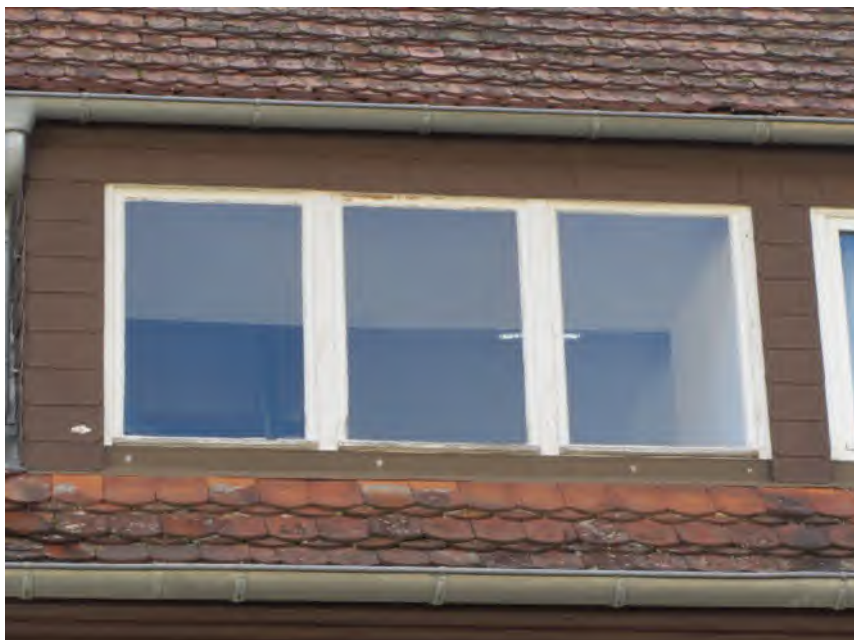
Bild 10: Zustand alte Treppenhaus-Fenster
