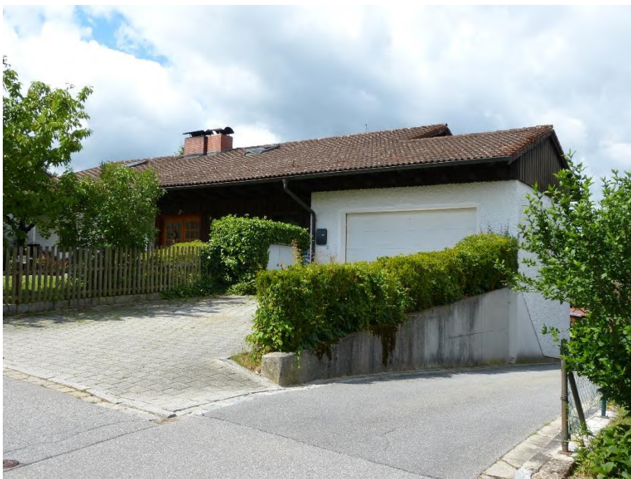
Gebäude 2: Garagenanbau mit Carport, Ansicht von Nordosten
