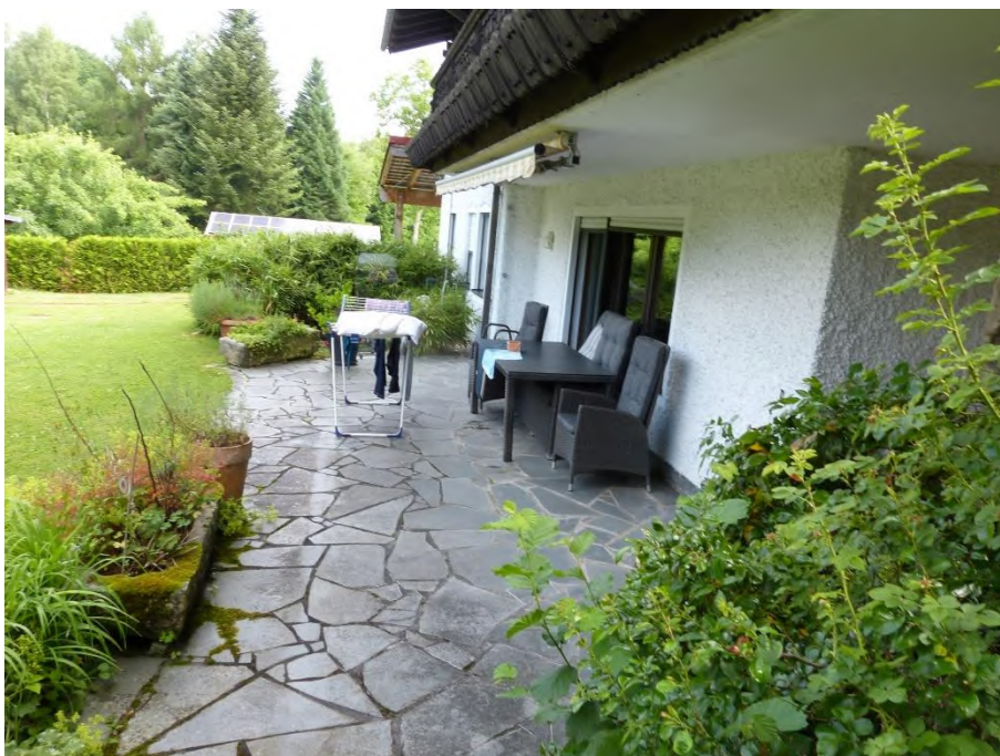
Außenanlagen, Terrasse im Untergeschoss nach Südwesten
