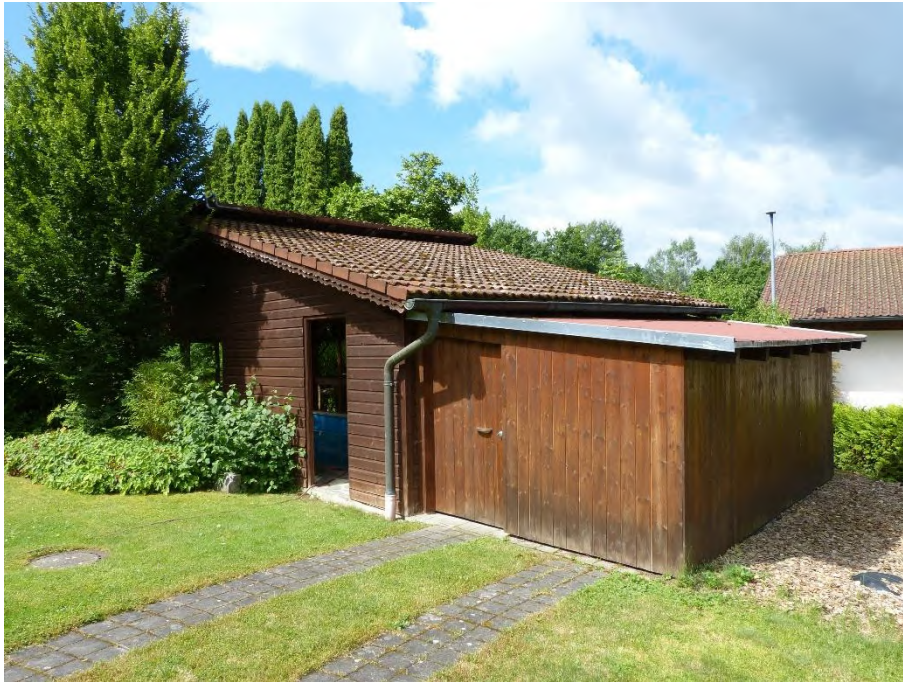
Gebäude 3: Schwimmbad mit Überdachung und Schuppenanbau, Ansicht von Süden
