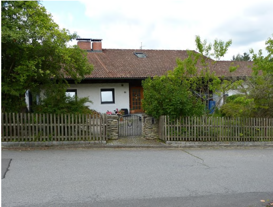
Gebäude 1: Einfamilienhaus mit Einliegerwohnung, Ansicht von Osten
