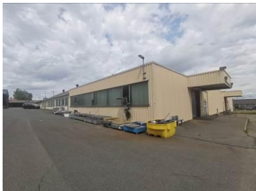
Bild des großen Lagergebäudes (Gebäude 5) von Südwesten
