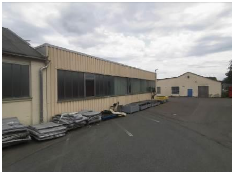
Ansicht des im Jahr 2001 erbauten Lagergebäudes (Gebäude Nr. 5) von Südwesten. Das Lagergebäude verfügt über eine Nutzfläche von insgesamt 770 m 2 . Im Bild rechts befindet sich das vor 1960 in Massivbauweise erbaute Lagergebäude
