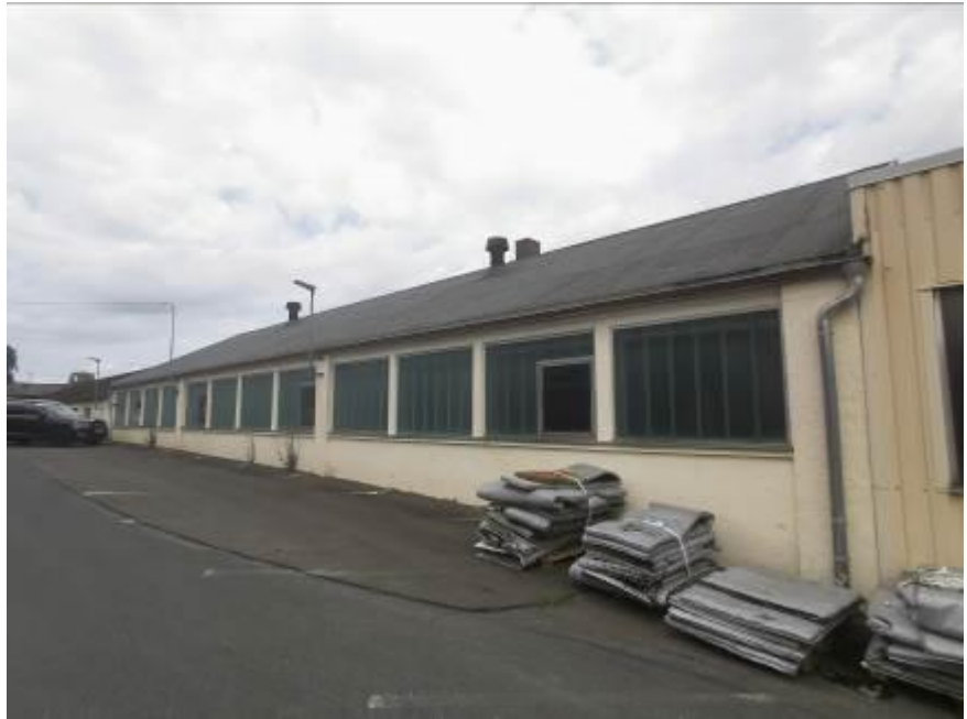
Ansicht der Shedhalle (Bj. 1951) von Süden
