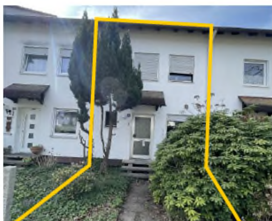
RMH zu A) Flst 900/98, Eingangsseite, Fassade N
