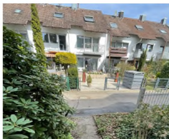
Standort Grundstückszugang zu A), Vorgartenbereich, Blick über Zuwegung zu Ab) Richtung benachbarter nördlicher Reihenanlage
