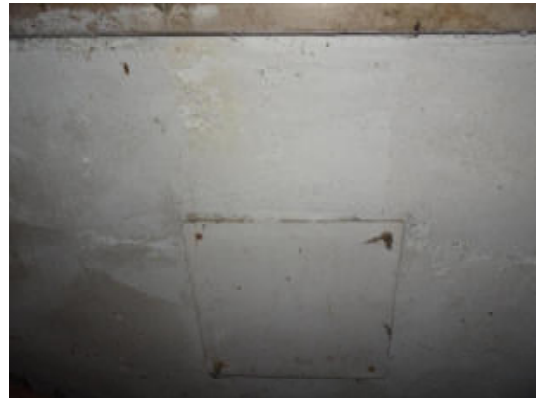
Feuchteschaden Kellerwand
