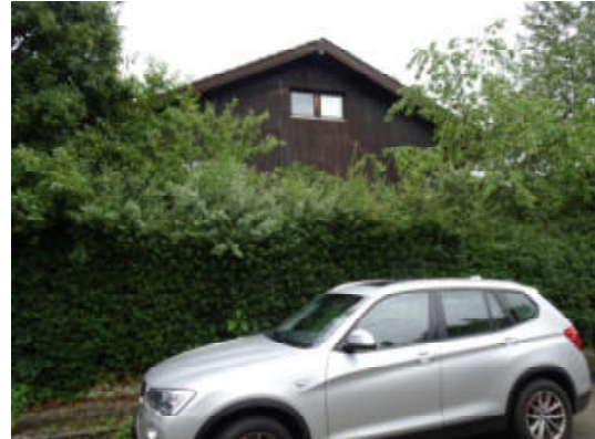
Nordwestseite des Gebäudes
