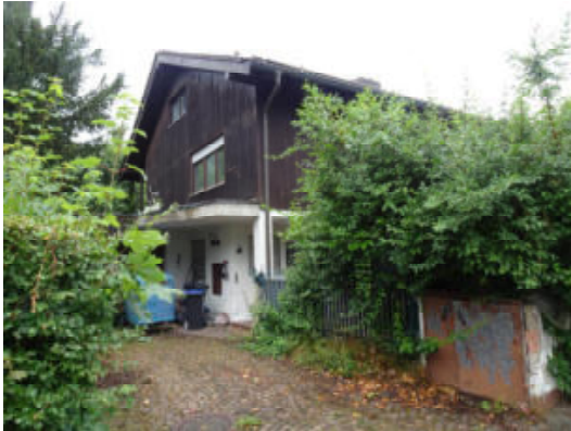
Nordost- und Südostseite des Gebäudes
