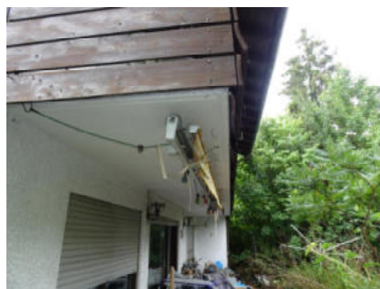
Feuchteschäden Balkon
