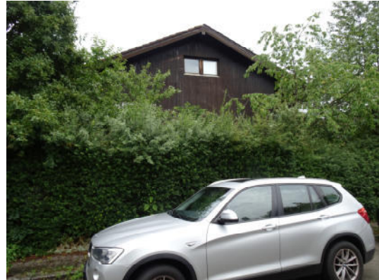
Nordwestseite des Gebäudes
