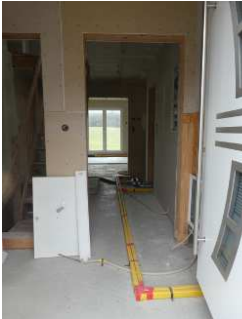
EG – Hauseingang - Windfang.
