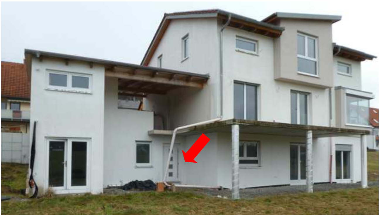
Ansicht Süd-/West mit Blick auf Zugang zur Einliegerwohnung im KG (siehe Pfeil).
