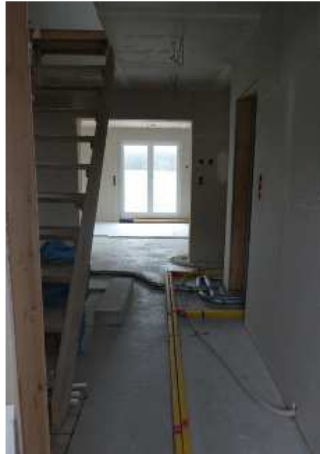
EG – Eingangsbereich – im Bild Bautreppe zu DG.
