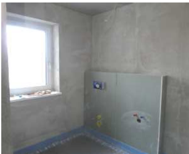
KG – Einliegerwohnung – Tageslichtbad mit Vorrichtungen für WC, Handwaschbecken und Dusche.
