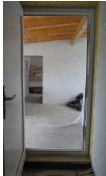
EG–Durchgang v. Wohnbereich zum Carport
