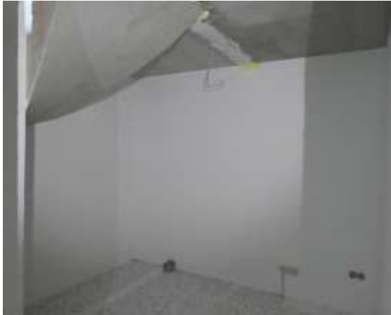
KG – Raum unter Kellertreppe.
