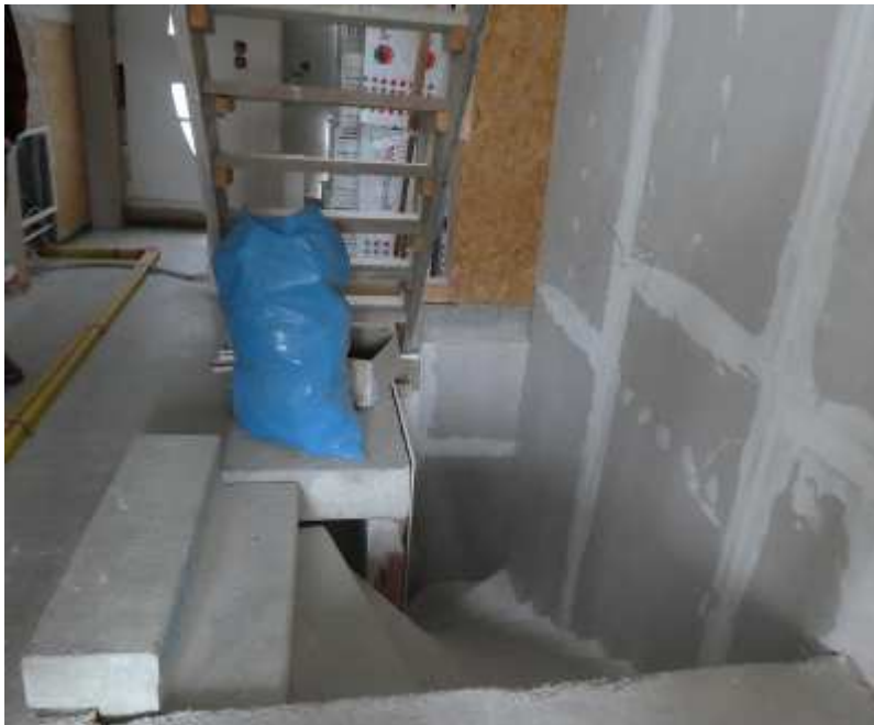
EG – Treppenhaus – mit Blick auf Stahlbetontreppe zu KG und Bautreppe (Holz) zu DG.
