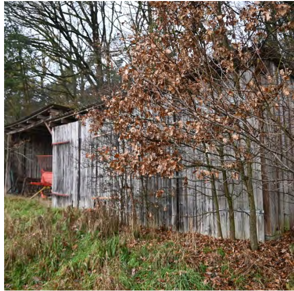
Defekte Holzverkleidung
