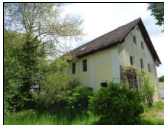
Ansicht von Südwesten (von Flst.-Nr. 25 aus gesehen)
