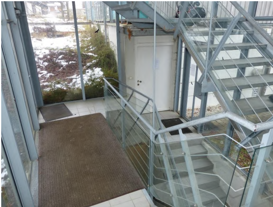
Gebäude 3 + 4: Ferienwohnanlage, Innenaufnahme Treppenhaus
