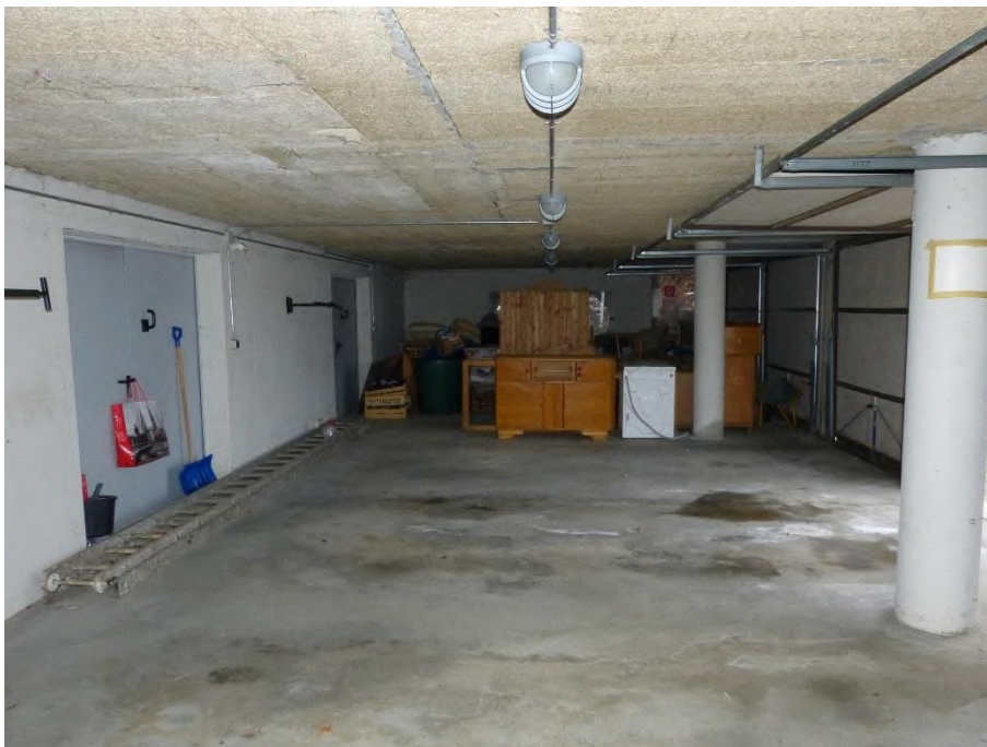
Gebäude 4: Ferienwohnanlage, Innenaufnahme Garagen im Untergeschoss
