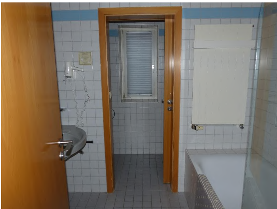
Gebäude 4: Ferienwohnanlage, Innenaufnahme Bad im Erdgeschoss
