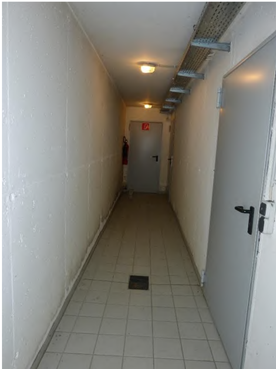
Gebäude 4: Ferienwohnanlage, Innenaufnahme Flur im Untergeschoss
