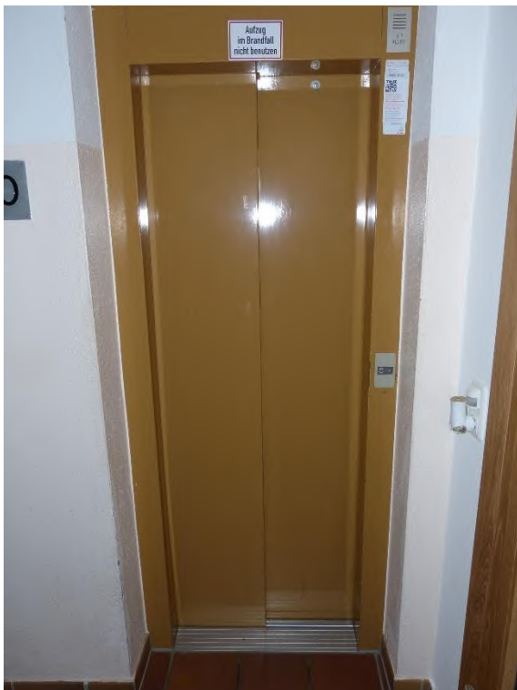
Gebäude 1: Hotelgebäude, Innenaufnahme Personenaufzug im Treppenhaus
