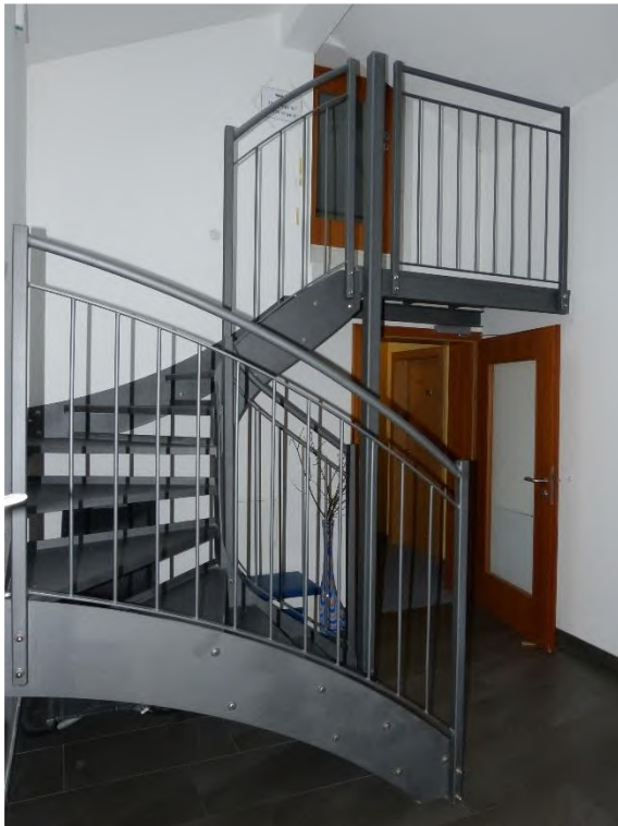
Gebäude 1: Hotelgebäude, Innenaufnahme Fluchttreppe im Dachgeschoss
