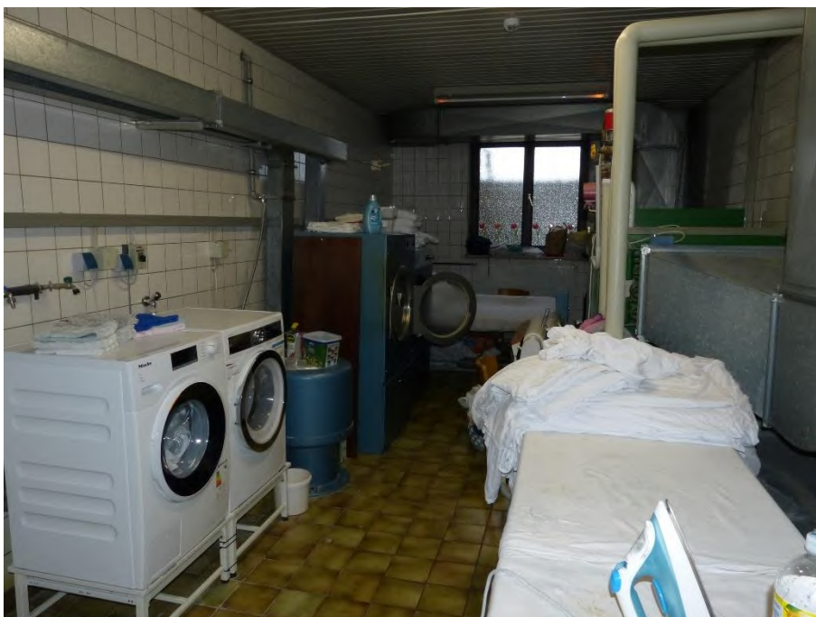
Gebäude 1: Hotelgebäude, Innenaufnahme Waschraum im Kellergeschoss
