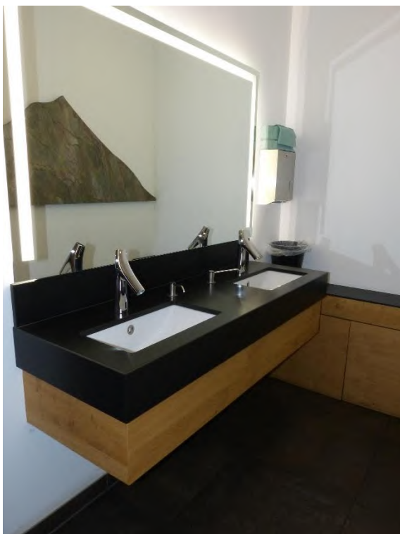
Gebäude 1: Hotelgebäude, Innenaufnahme Gäste-WC's für Restaurant im Kellergeschoss
