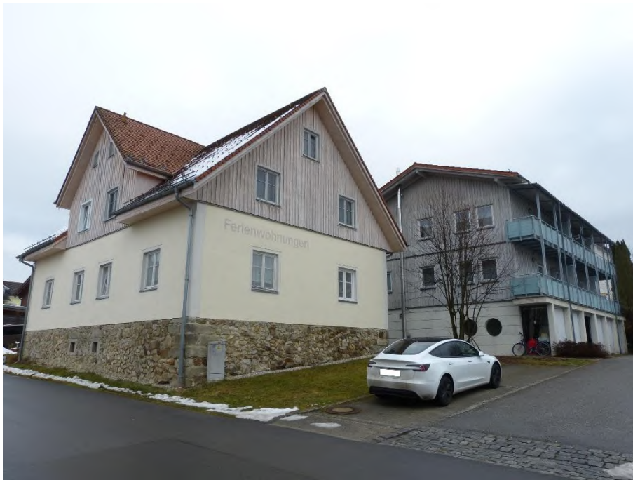
Gebäude 3 + 4: Ferienwohnanlage, Ansicht von Südwesten
