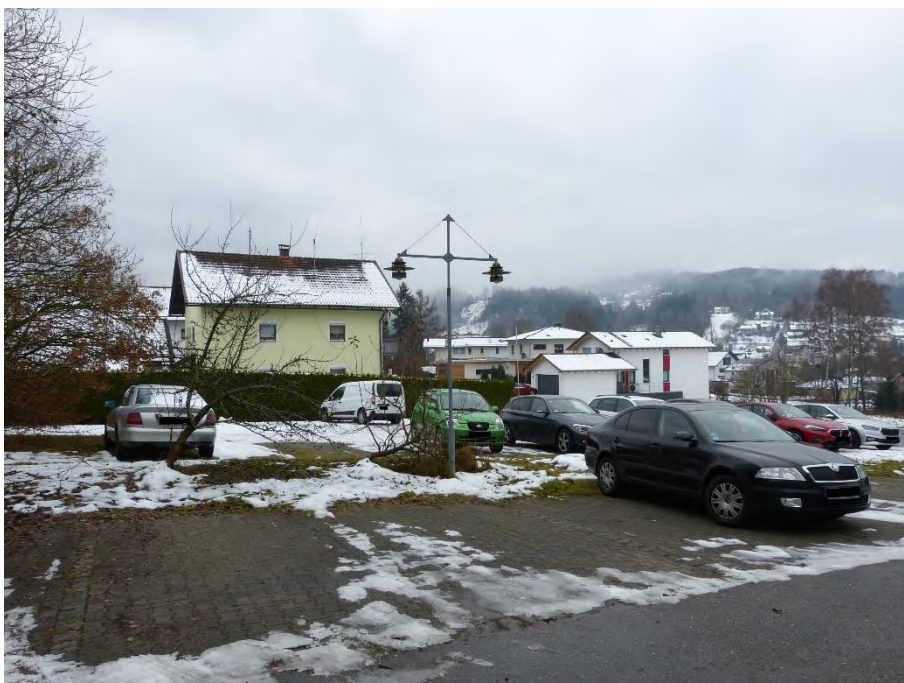
Außenanlagen, Parkplätze nach Süden
