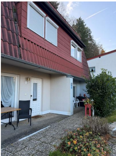
Zugang zu SE-Nr. 6 – Nord-Westansicht
