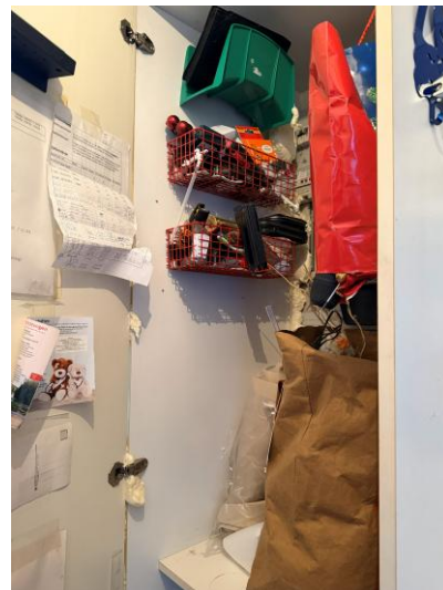
„Isolierarbeiten“ im Schrank - Windfang
