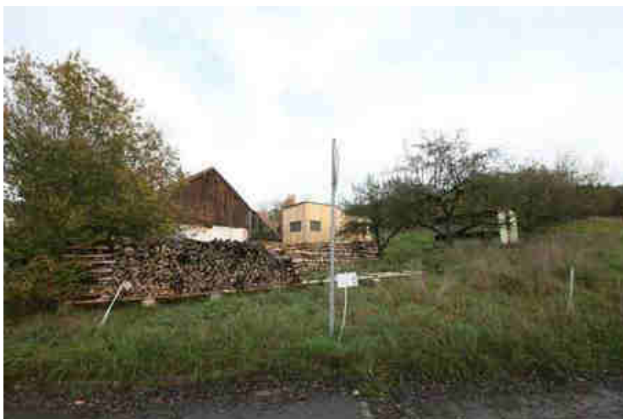
Blick von Süden auf FlstNr. 547/2, rechts im Bild Nebengebäude (Gebäude 3), links im Bild landwirtschaftliches Nebengebäude auf FlstNr. 547/1
