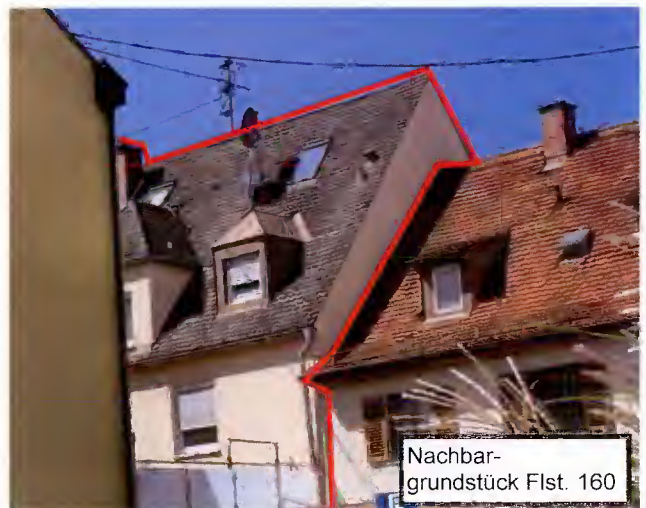
Blick auf WGH aus Richtung NO mit Gebäude-Anbau Nachbargrundstück Flst. 160
