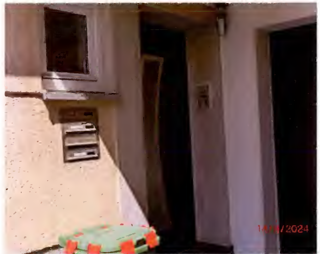
Hauseingang an der Ostfassade
