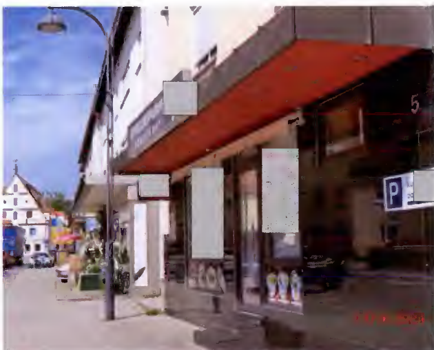
Straßenfassade mit Eingang EG Schnellimbiss
