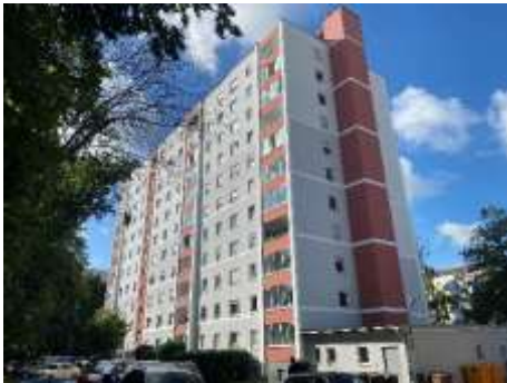
Bewertungsobjekt (Ansicht von Nordosten)
