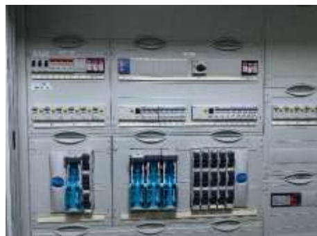
Hauptsicherungskasten
