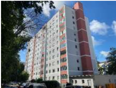
Bewertungsobjekt (Ansicht von Nordosten)
