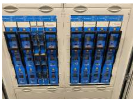
Hauptsicherungskasten
