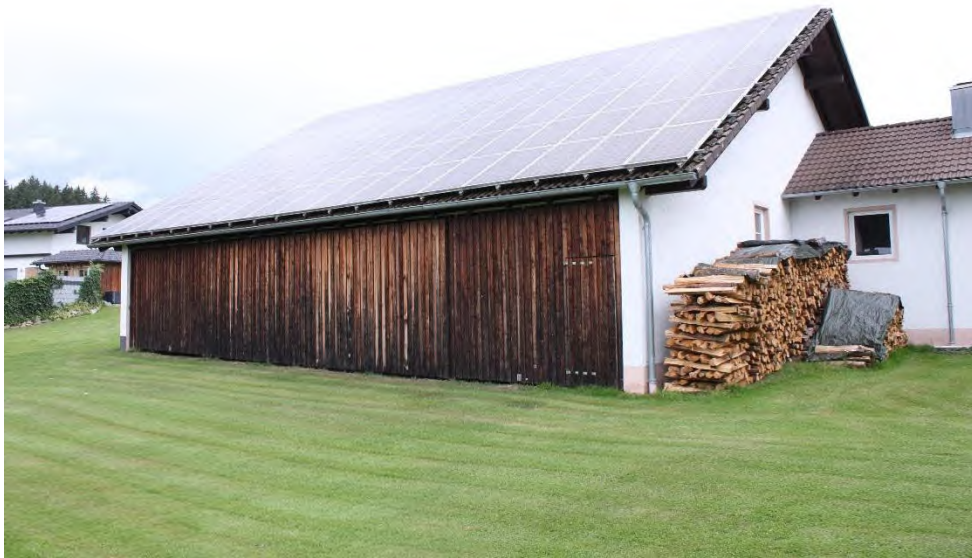
Bild 5: Halle von Süden (PV-Anlage bleibt unberücksichtigt)
