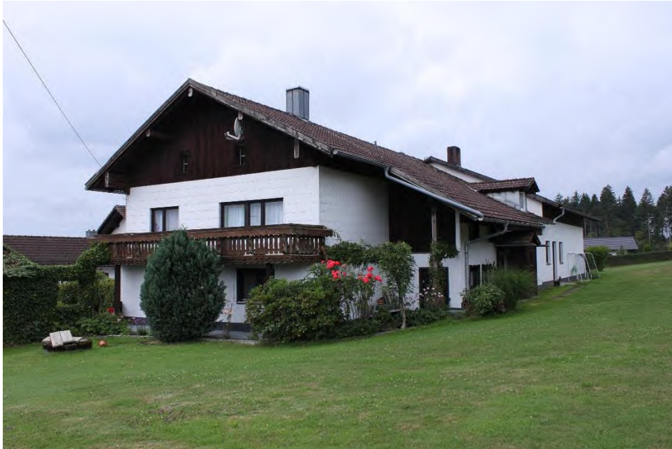
Bild 1: Wohnhausaltbau: Ansicht von Nordosten
