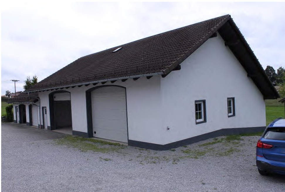
Bild 4: Halle und Garagen von Nordwesten
