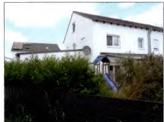
West- und Südfassade DHH
