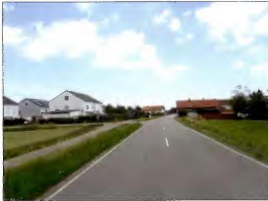
Staatsstraße 2114, Blickrichtung Westen
